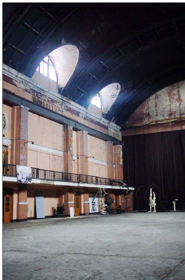
Ryc. 6. Sala modrzewiowa – główna hala maszyn; fot. D. Oleś 2019.
