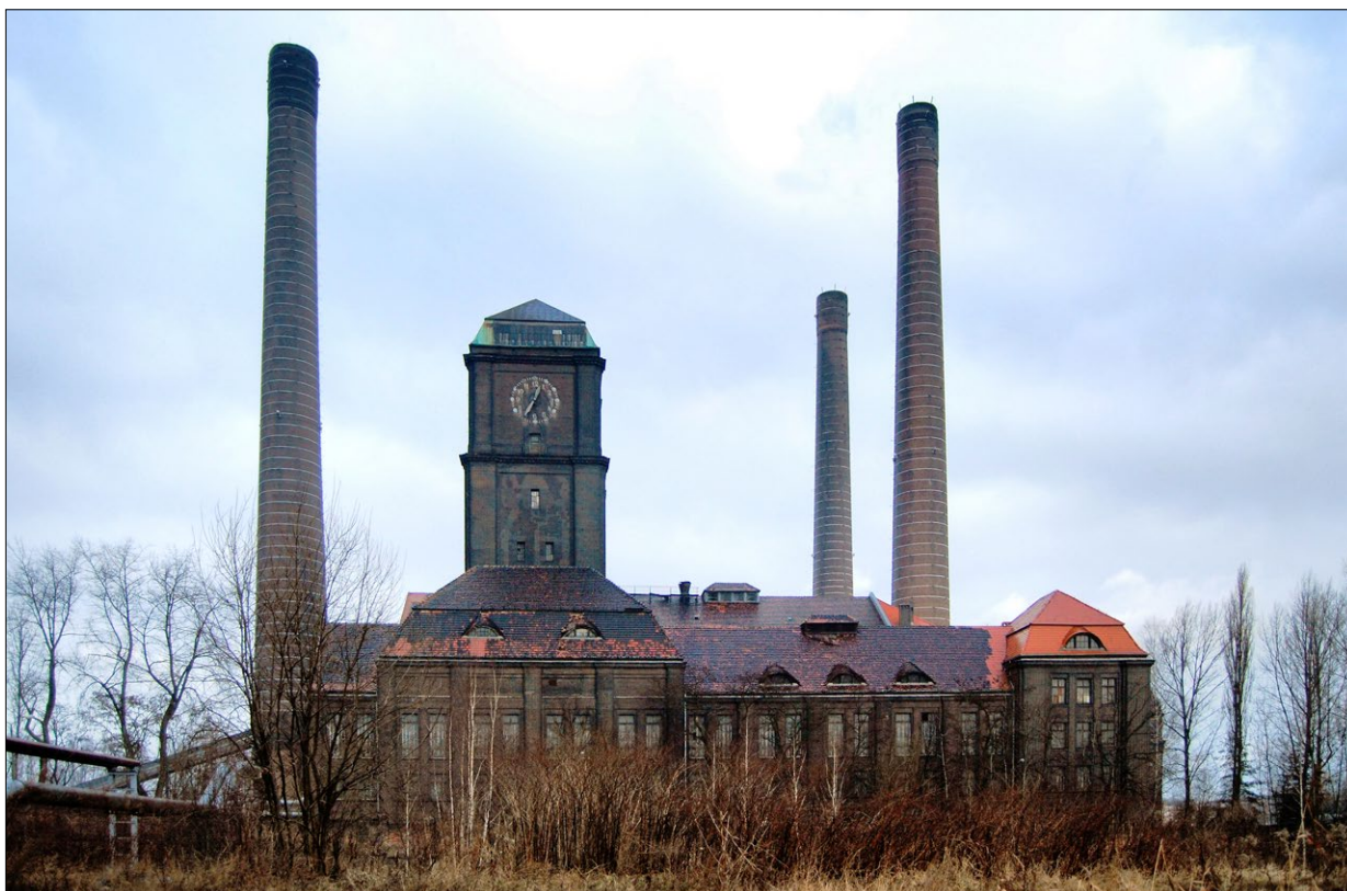
Ryc. 5. Elewacja południowa zespołu zabudowy Elektrociepłowni Szombierki; fot. D. Oleś 2016.
