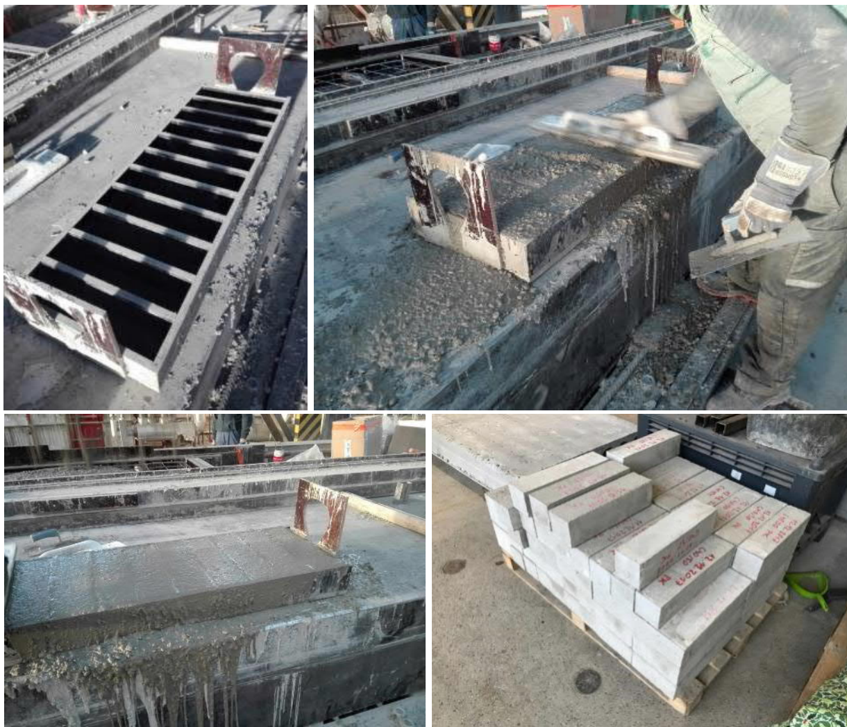
Rys. 4.2. Przygotowanie i wykonanie elementów betonowych
