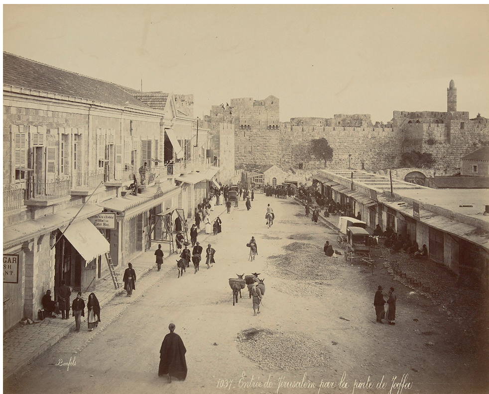
Il. 5. Osmańska zabudowa w rejonie na zewnątrz murów Starego Miasta przy ulicy wiodącej do Bramy Jaffajskiej (ze zbiorów prywatnych autora)
