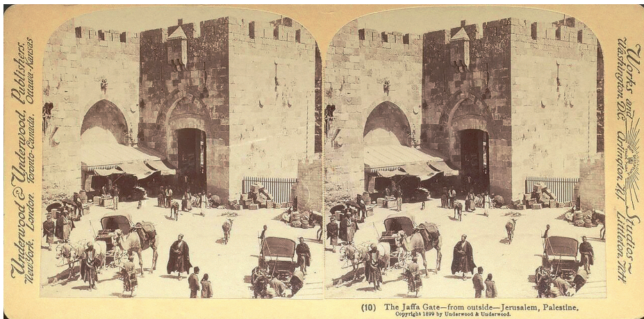
Il. 2. Widok Bramy Jaffajskiej od strony zewnętrznej murów przed budową wieży zegarowej. Karta stereoskopowa z 1899 r. (ze zbiorów prywatnych autora)
