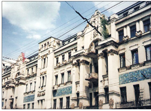
Fig. 2. Majolica stripes on the main facade of the building at 6 Sumskaya Street in Kharkiv; photo by Yu. Ivashko 2017. Ryc. 2. Pasy z majoliki na głównej fasadzie budynku przy ul. Sumskiej 6 w Charkowie; fot. J. Iwaszko 2017.
