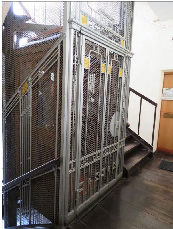
Ryc. 4. Poznań, kamienica mieszkalna, ul. Wielka 21, szyb dźwigowy, oryginalne drzwi szybowe wewnątrz klatki schodowej, stan na rok 2016; fot. K. Pietrzak.
