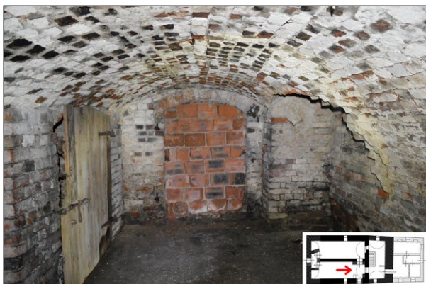
Fig. 3. The cellars of so-called "new manor," south chamber, eastward view; photo by the author. Ryc. 3. Piwnice tzw. nowego dworu, komora południowa, widok w kierunku wschodnim; fot. autor.
