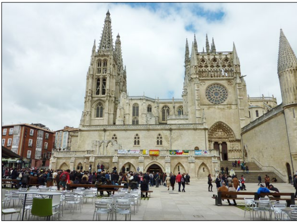
Fig. 1. South elevation of the Cathedral of Burgos from the Plaza Rey San Fernando; photo by I. Mora Moreno. Ryc. 1. Południowa elewacja katedry w Burgos od strony Plaza Rey San Fernando; fot. I. Mora Moreno.
