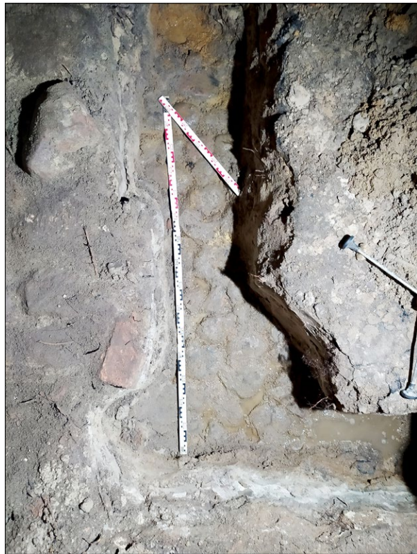
Fig. 6. The cellars of so-called “new manor,” southern chamber, excavation b; photo by the author. Ryc. 6. Piwnice tzw. nowego dworu, południowa komora, odkrywka b; fot. autor.
