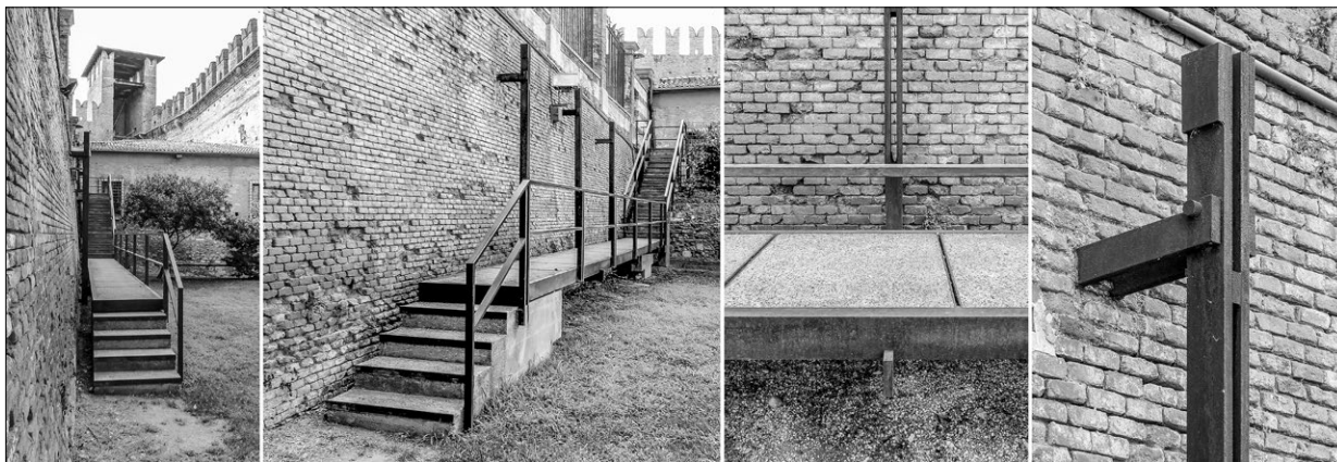
Fig. 7. Details of the concrete staircase of Scarpa's new intervention in Castelvecchio in Verona, 2015; photos by: A. Ros Campos. Ryc. 7. Detale betonowych schodów po interwencji Scarpy w Castelvecchio w Weronie, 2015; fot. A. Ros Campos.
