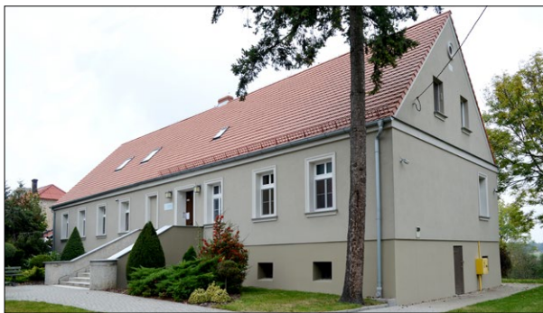
Fig. 1. The kindergarten building, containing the remains of the so-called "new manor," view from the southeast; photo by the author. Ryc. 1. Budynek przedszkola zawierający relikty tzw. nowego dworu, widok od południowego wschodu; fot. autor.
