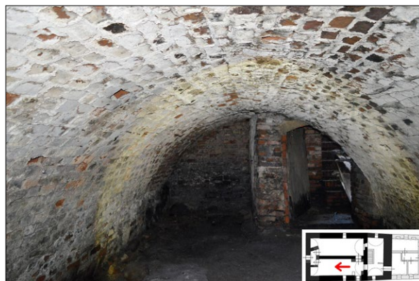
Fig. 4. The cellars of so-called "new manor," south chamber, westward view; photo by the author. Ryc. 4. Piwnice tzw. nowego dworu, komora południowa, widok w kierunku zachodnim; fot. autor.
