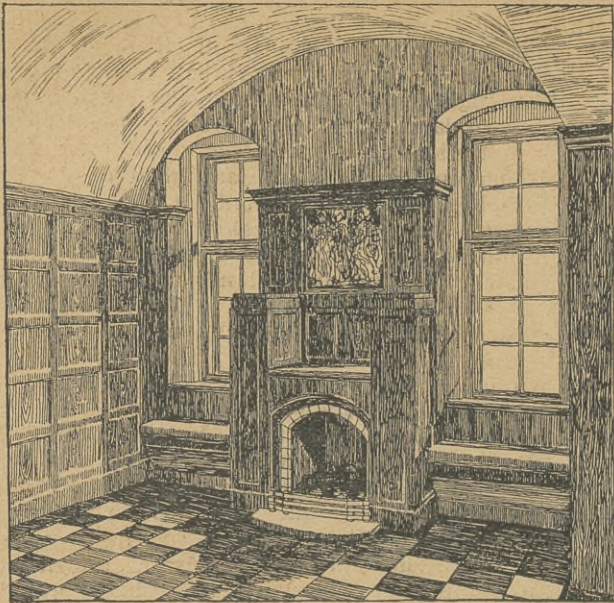
Abb. 102. Kamin mit Holzumkleidung in einer Halle
