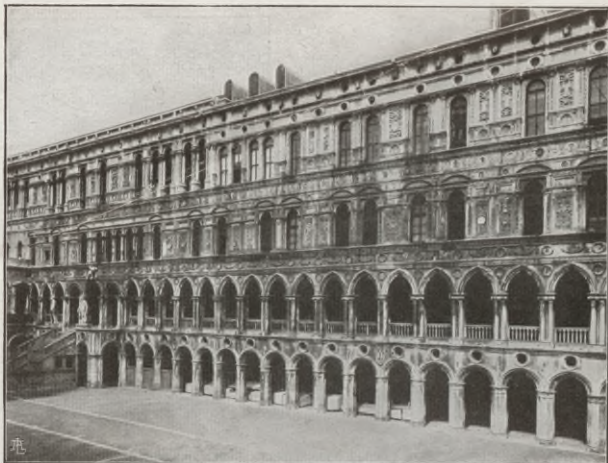
Façade im Hofe des Palastes.
