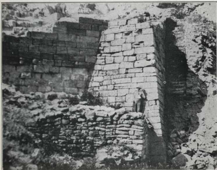
(Im Vordergrund) Mauer der VIII. Schicht.
