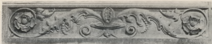
22. Sockelfüllung an der Stürzel-Kapelle.
