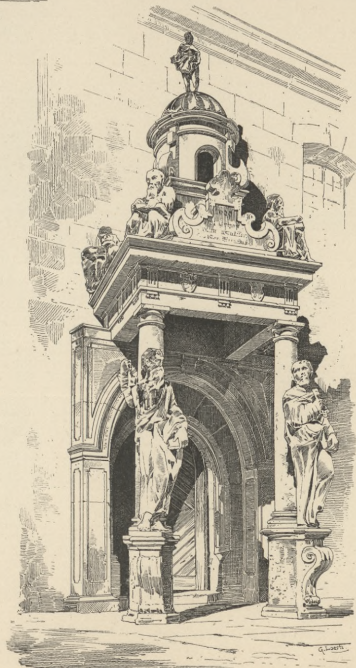
Hemmingen. Vorhalle der Kirche.
