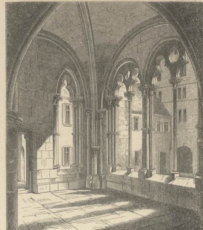
Inneres der Vorhalle.
