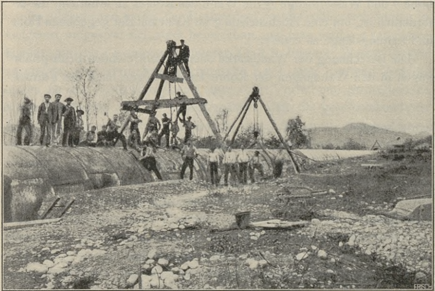
Abb. 81. Rohr von 3,3 m Durchmesser aus genietetem Stahlblech für die Druckleitung der Kraftanlage von Champ (Isère).
