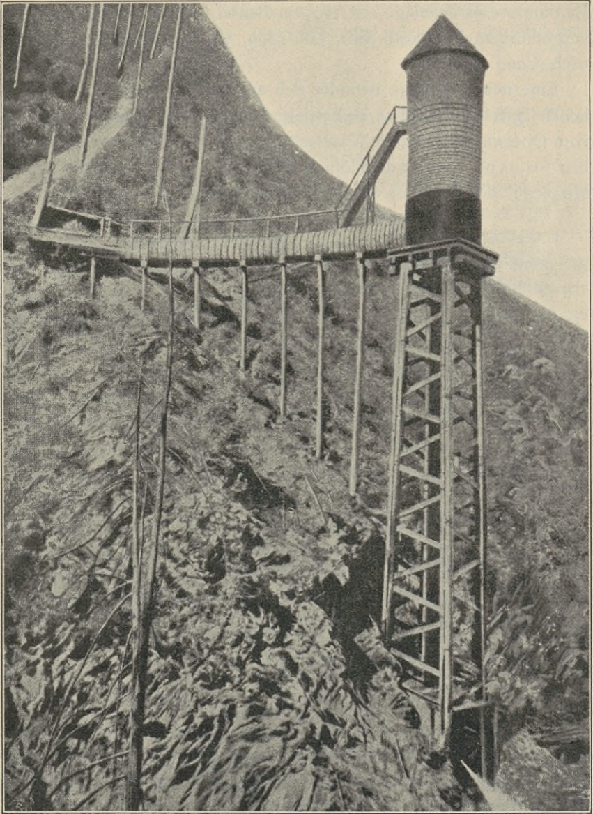
Abb. 122. Hydraulische Luftkompressionsanlage in Ainsworth (British Columbia).
