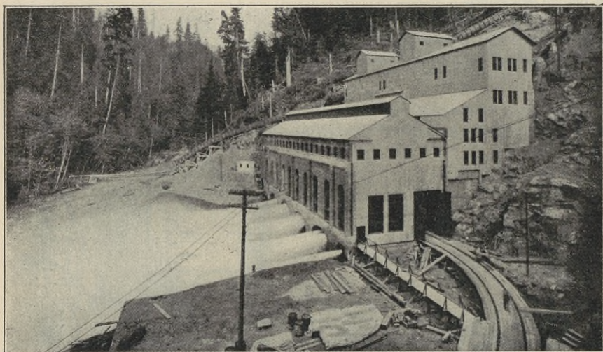
Abb. 176. Das Elektrizitätswerk am Puyallup-Flusse (Washington). Turbinen im Betriebe.
