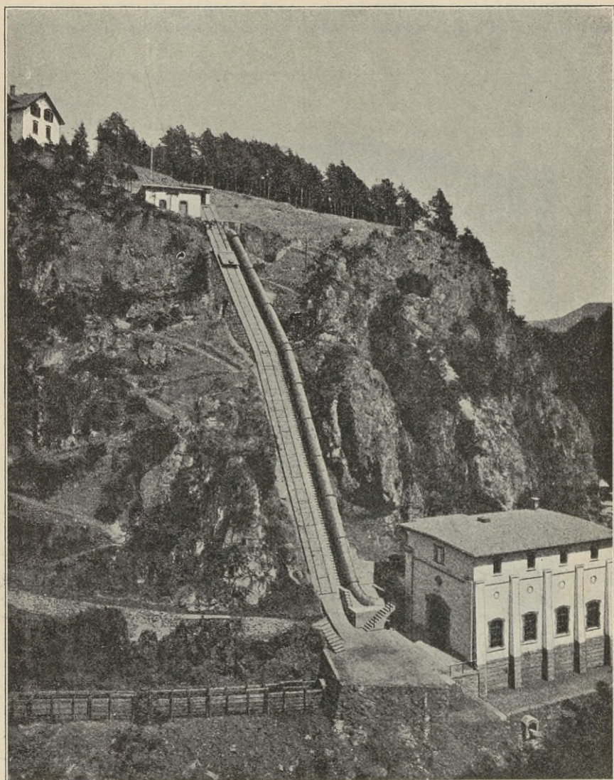
Abb. 110. Die Hochdruckleitung vom Wasserschloß zum Kraftgebäude des Elektrizitätswerkes der Papierfabrik Albruck (Schwarzwald).
