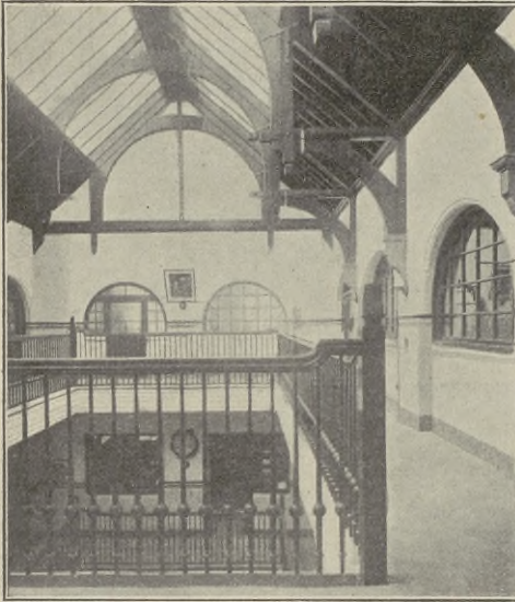
Abb. 137. Halle im englischen Schulhaus.
