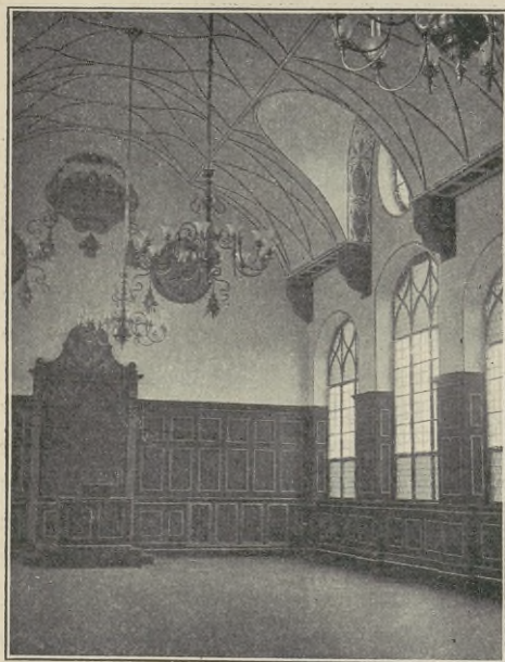
Abb. 142. Kürnberg, Schule Sindelgasse.
