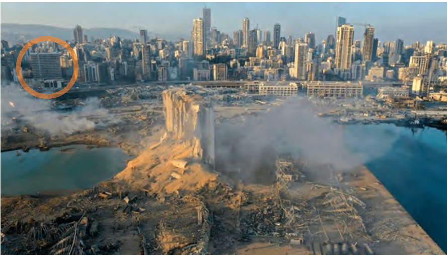
Zniszczony port w Bejrucie, z budynkiem Electricité du Liban (oznaczony, z lewej strony) w tle
