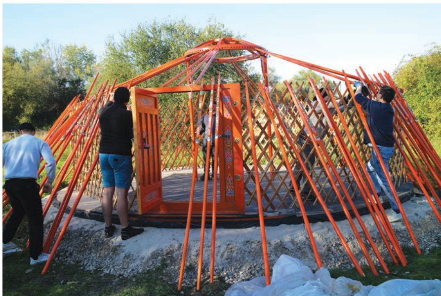
Tak zaczyna się budowa jurty
