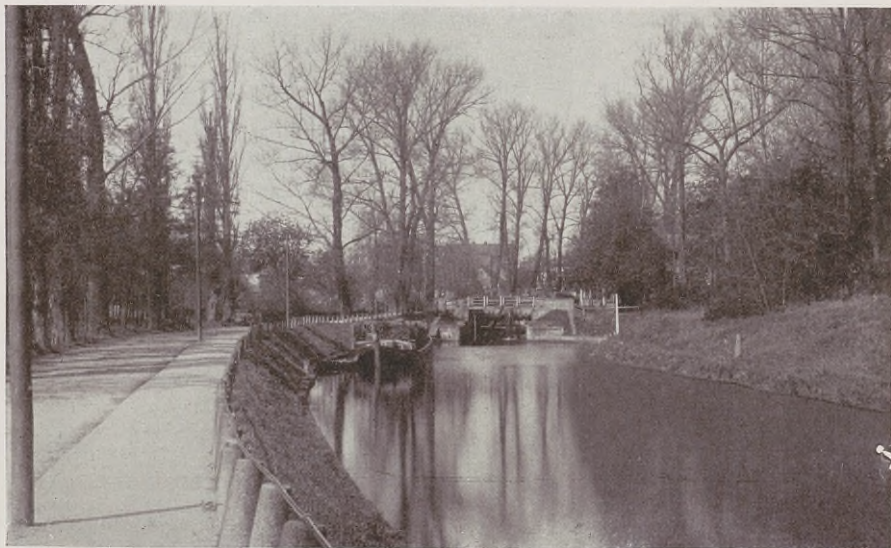
Bromberger Kanal vor der III. Schleuse.
