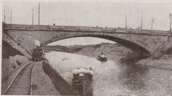
Brücke über den Teltowkanal.
