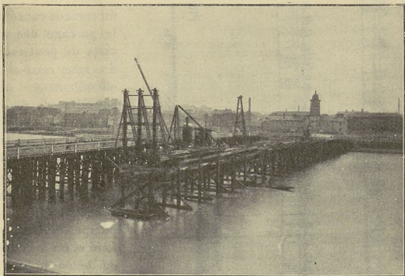
Fig. 270. — Construction du pont provisoire en bois.
