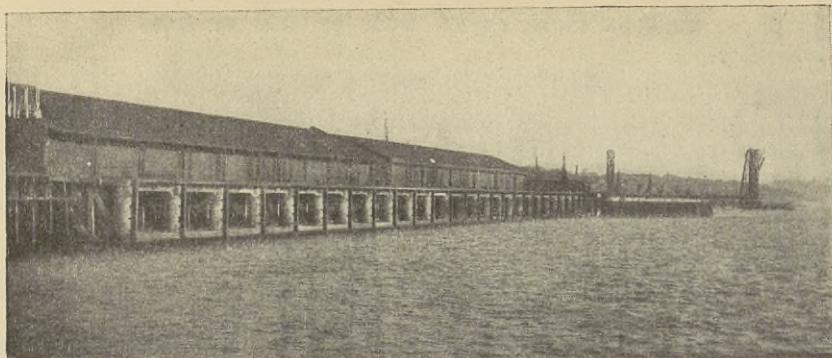
Fig. 339. — Mur de quai à Dundee.
