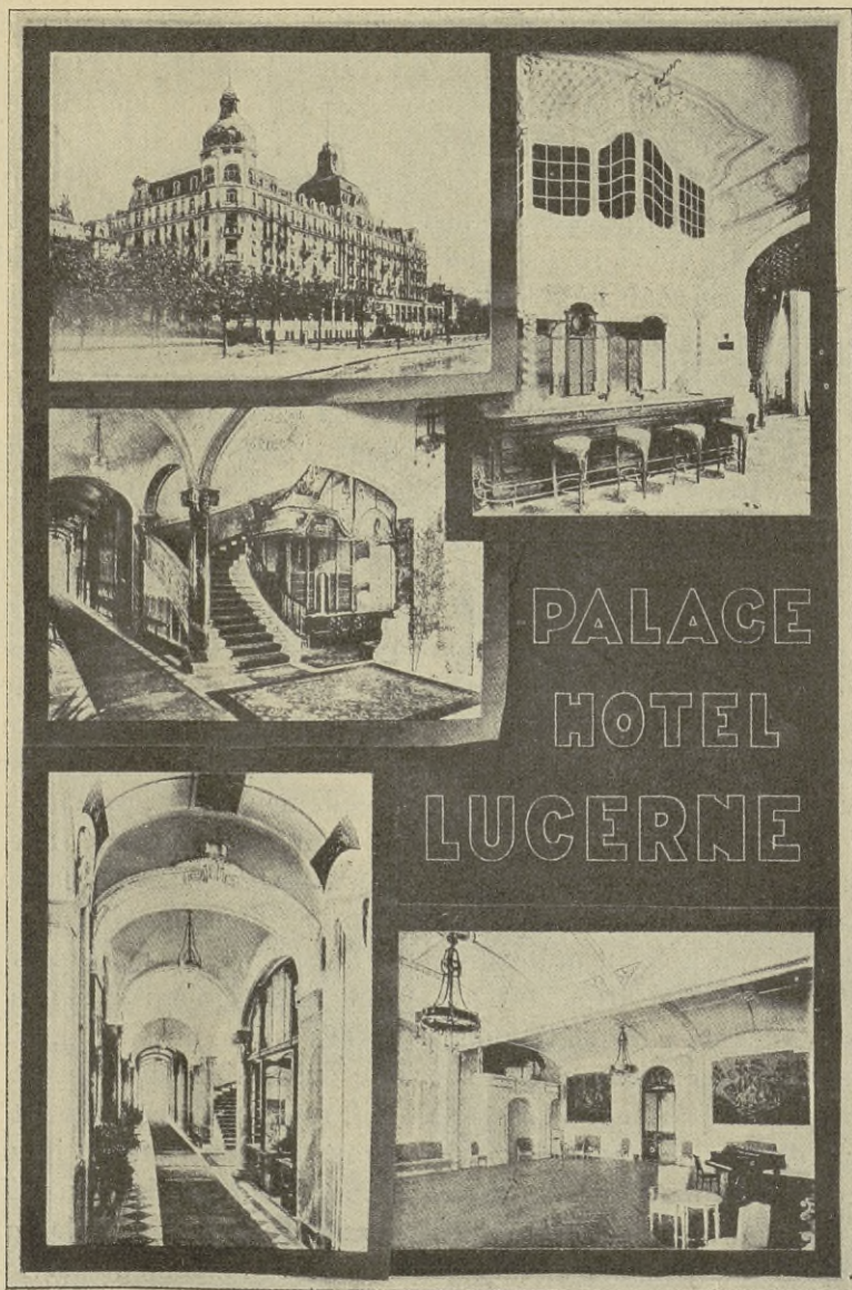
Fig. 195. — Vue extérieure et vues intérieures du Palace Hôtel à Lucerne.
