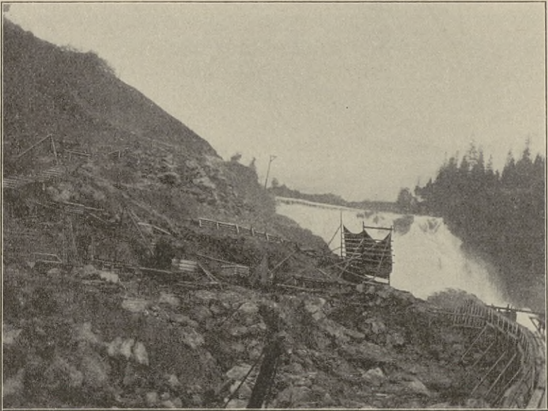
Abb. 105. Unterer Lerfos. Ansicht des Falles und des Bauplatzes für das Turbinenhaus.
