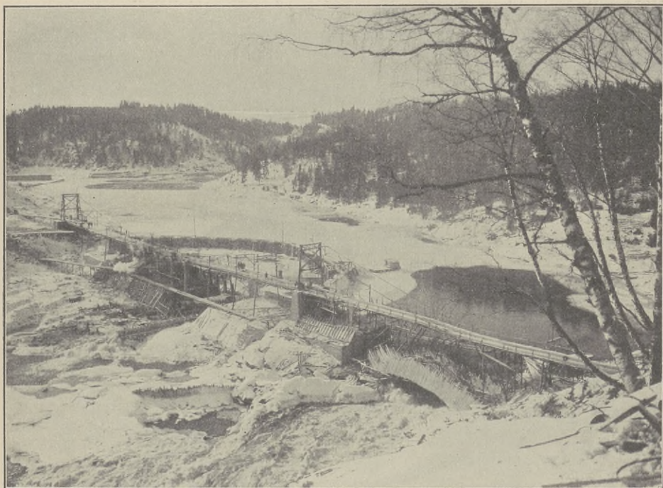
Abb. 123. Vammafos. Bauzustand im April 1908.
