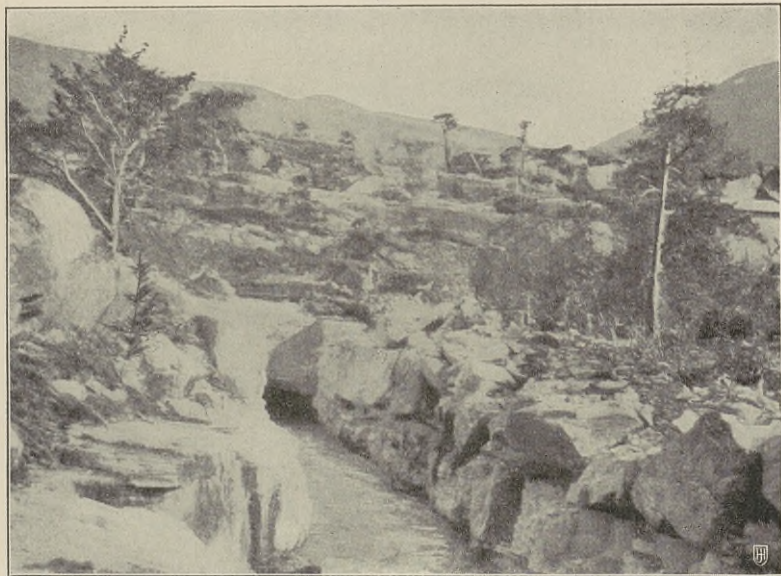
Abb. 78. Tyssefos. Auslauf des Tunnels aus dem Ringedalssee.
