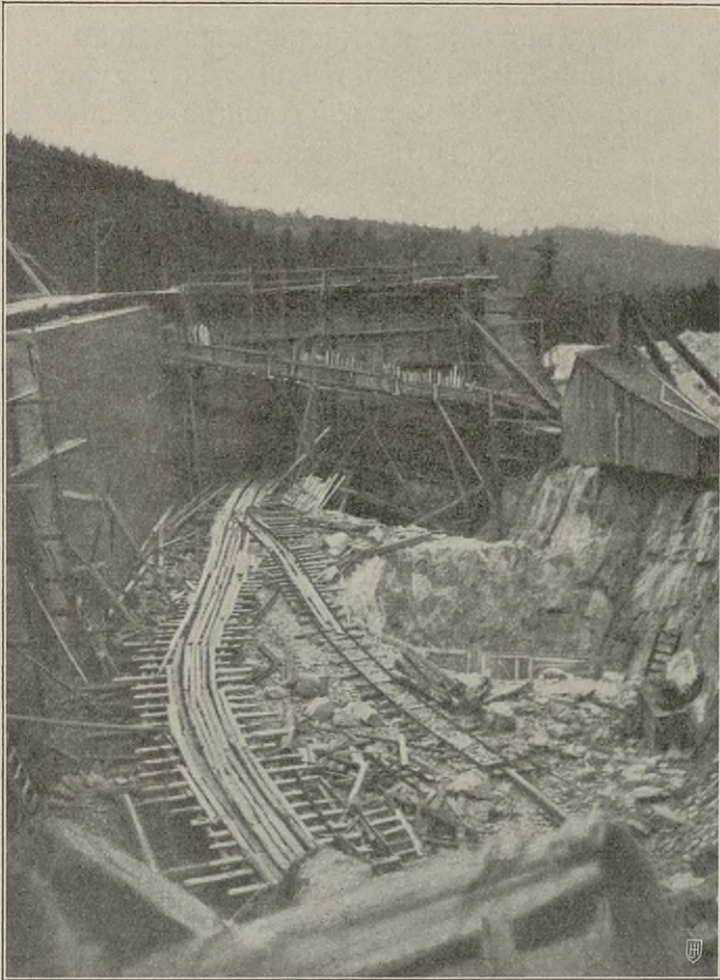
Abb. 23. Svaelfos. Verteilungsbecken im Bau 1906.
