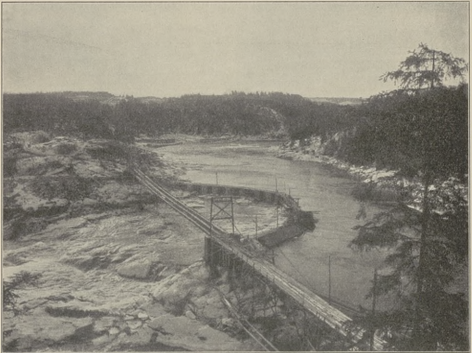
Abb. 122. Vammafos. Bauzustand im Februar 1908.
