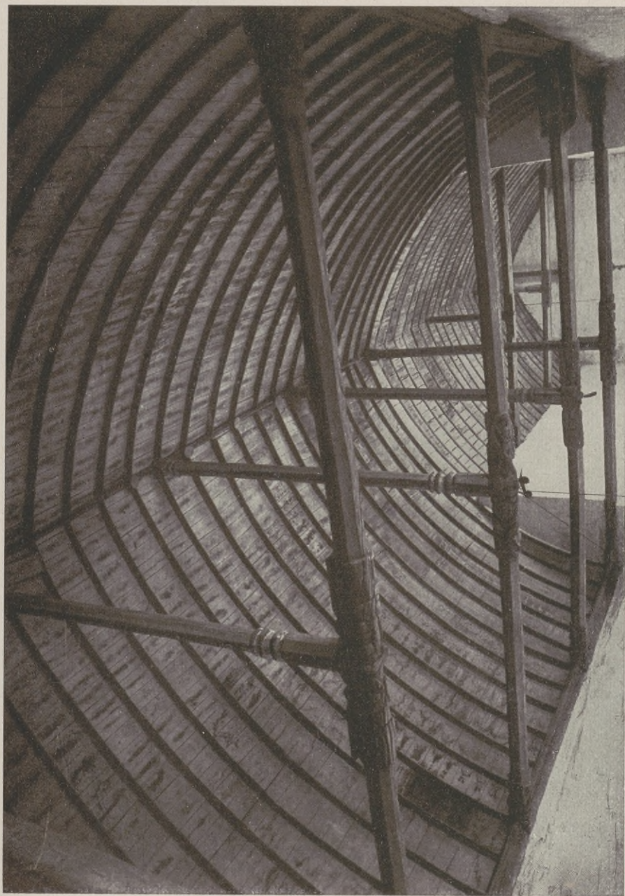
61. Selomes, gewölbte Decke der Kirche, Holz
