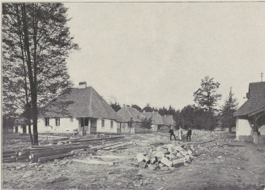
Die Gruppestraße im Bau.
