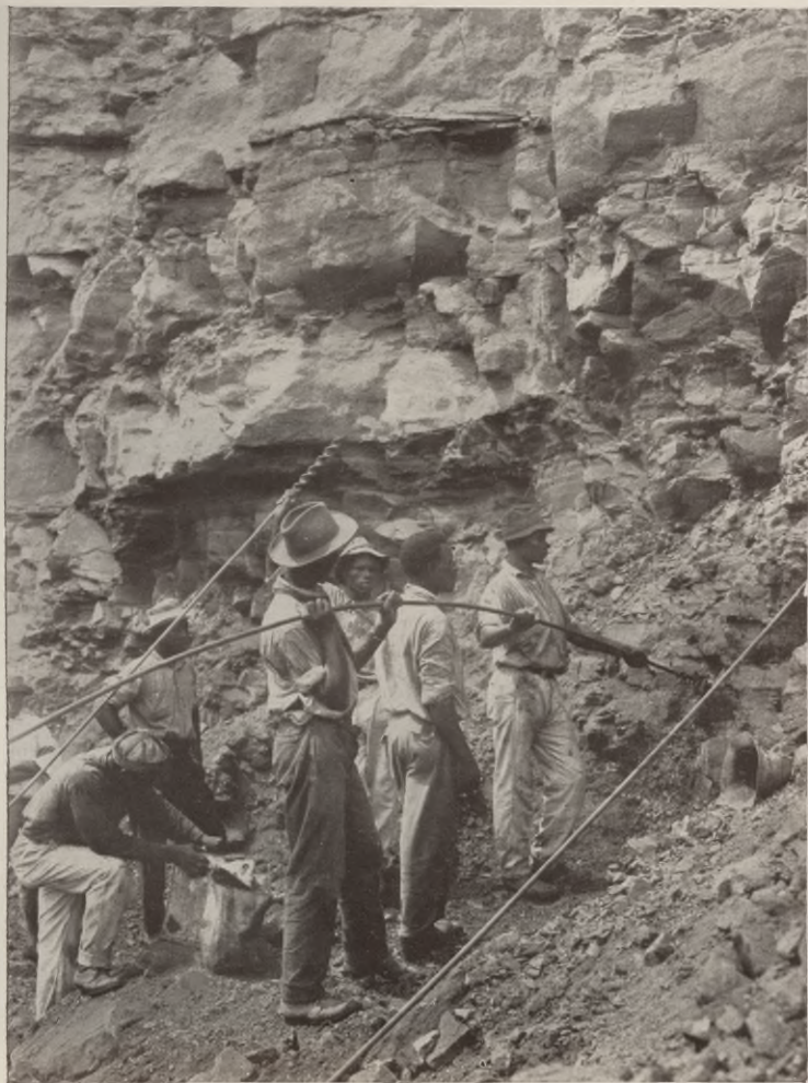
Vorbereitungen zu Sprengarbeiten im Culebra-Durchbruch.
