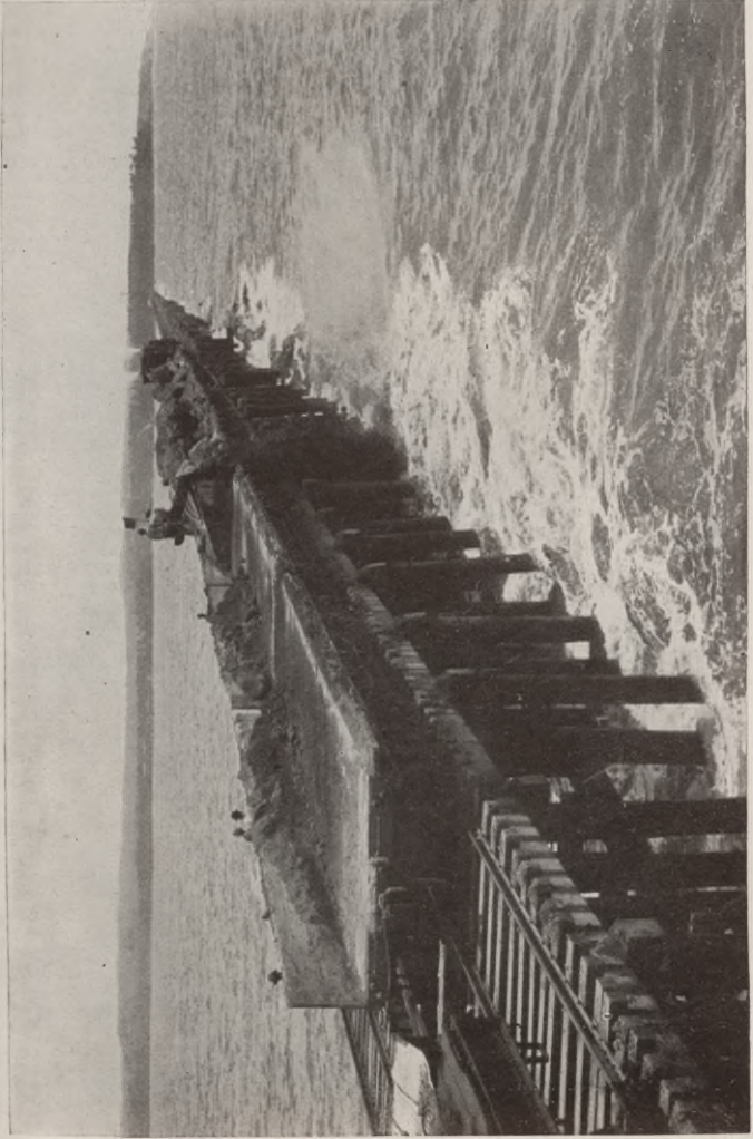
Wellenbrecher zum Schutze des Kanaleingangs auf der atlantischen Seite.
