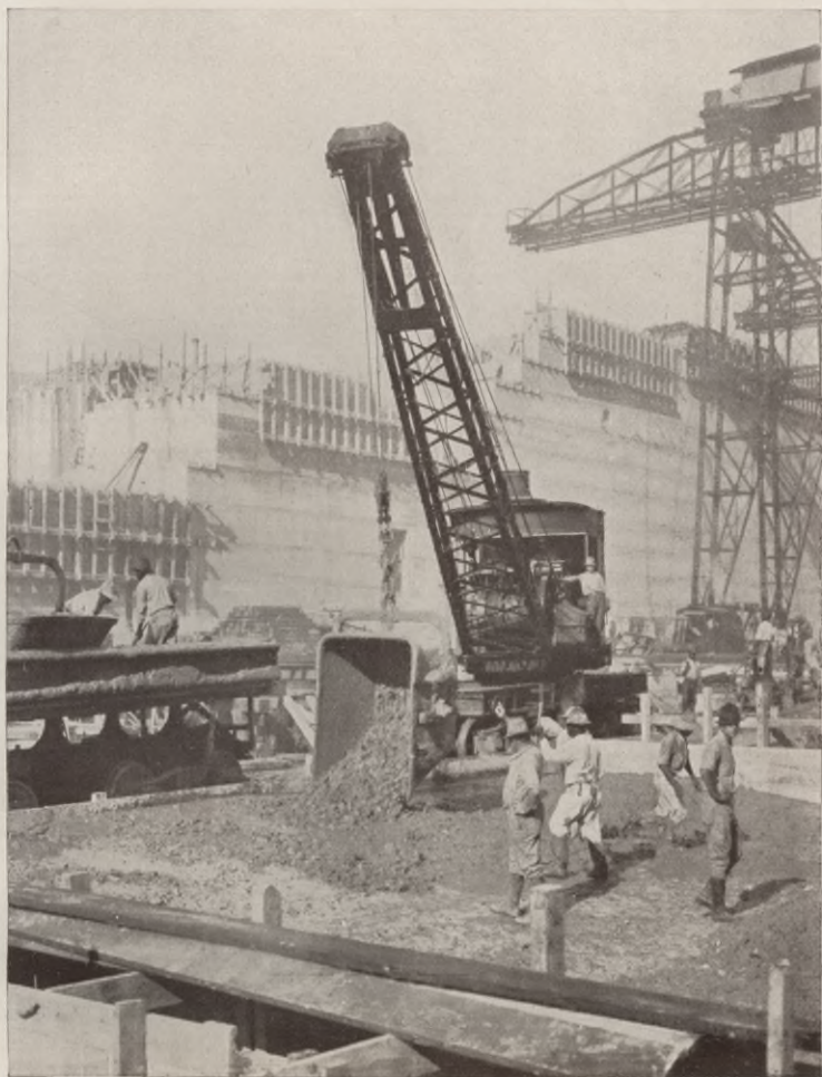
Heranschaffen von Beton zum Bau der Pedro Miguel-Schleuse.
