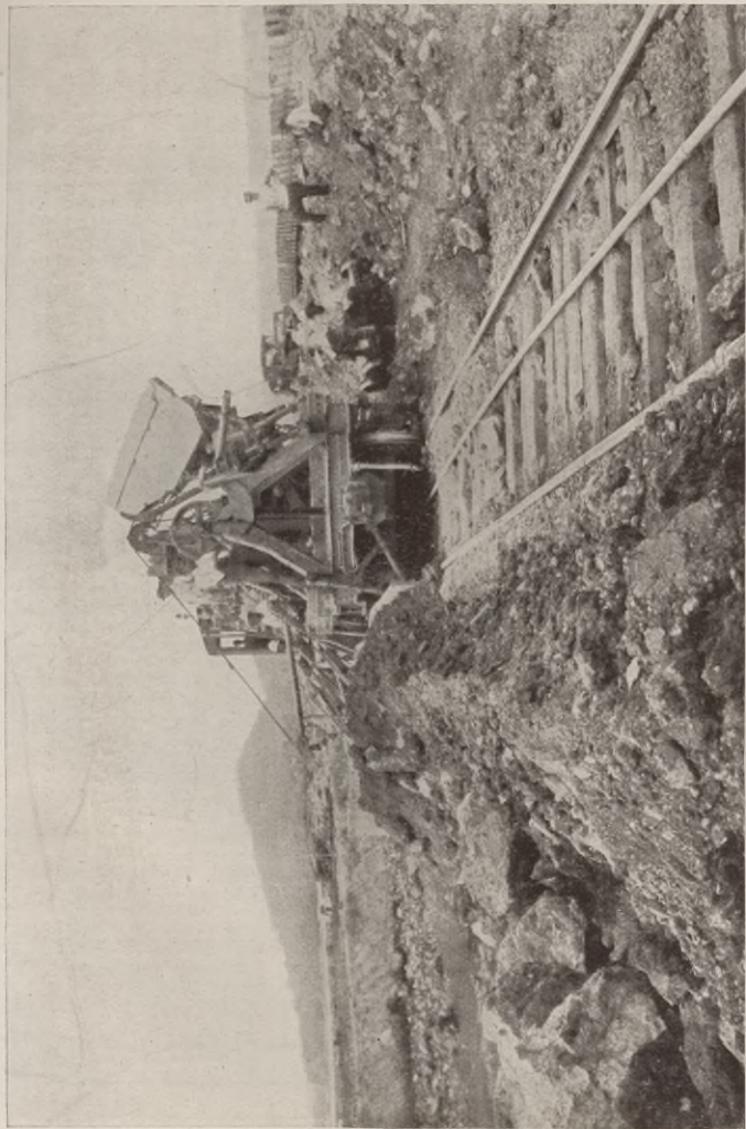
Stampfmaschine zur Verkleinerung von Fels- und Erdmassen.
