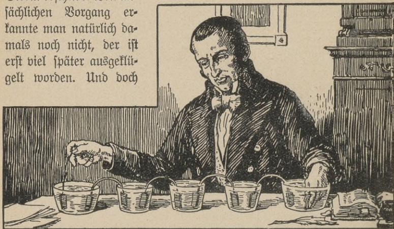
Abb. 20. Der Voltasche Becher- oder Tassenapparat, die Urform unserer galvanischen Elemente: je eine Kupfer- und Zinkplatte in angesäuertem Wasser. Der Strom wird auf unserer Abbildung durch den Körper des Experimentierenden geschlossen.
