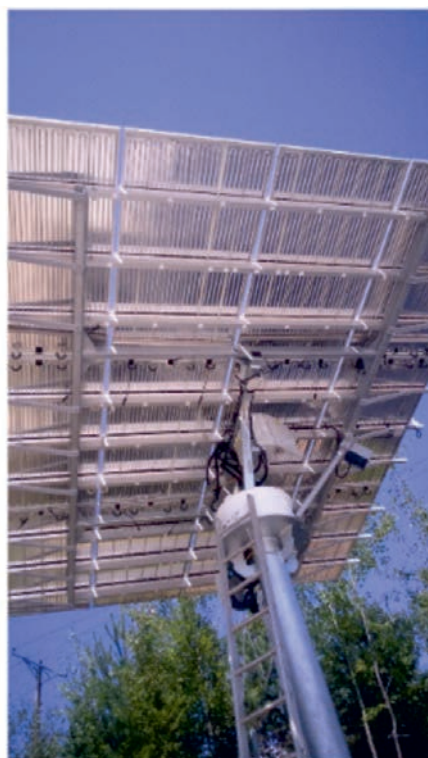
Panele fotowoltaiczne osadzone na trackerach, podążające za słońcem w celu maksymalnego wykorzystania jego energii
