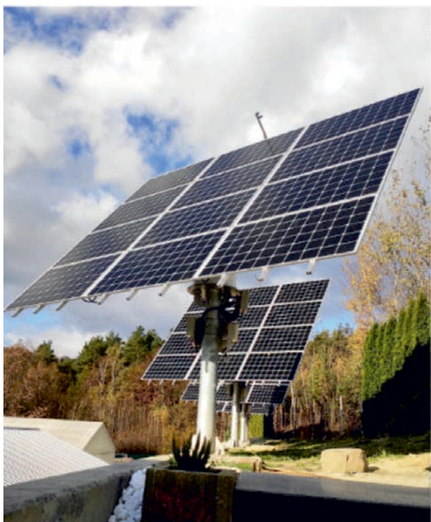
Panele fotowoltaiczne osadzone na trackerach, podążające za słońcem w celu maksymalnego wykorzystania jego energii
