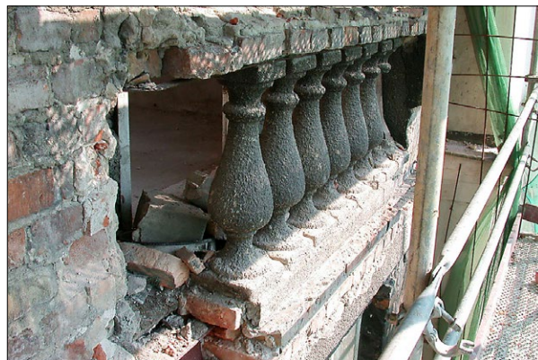
Ryc. 2. Detal architektoniczny w obrębie elewacji frontowej podlegający renowacji; fot. P. Przybysz. Fig. 2. Architectural detail within the front elevation subject to renovation; photo by P. Przybysz.
