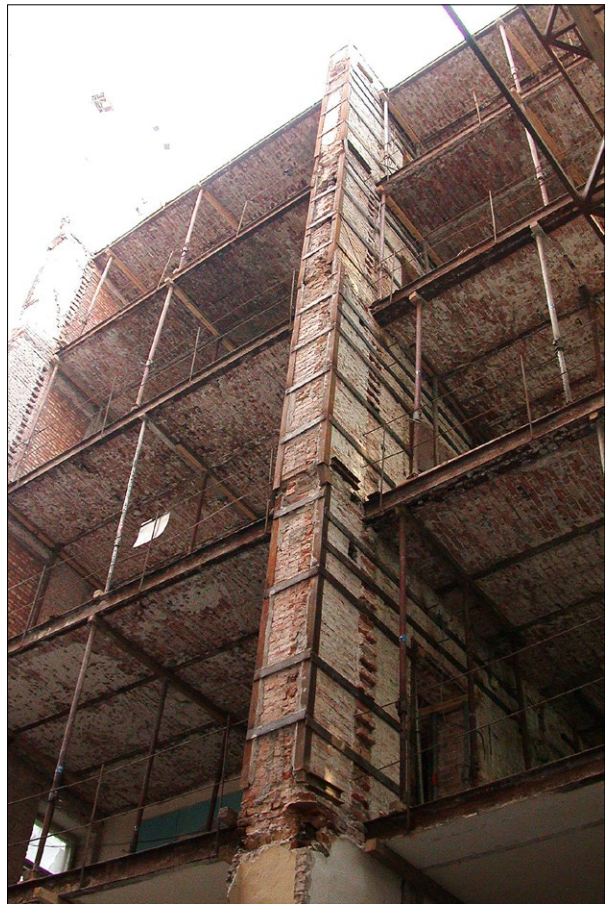
Ryc. 9. Wzmocnienie tymczasowe konstrukcji budynku; fot. P. Przybysz.
