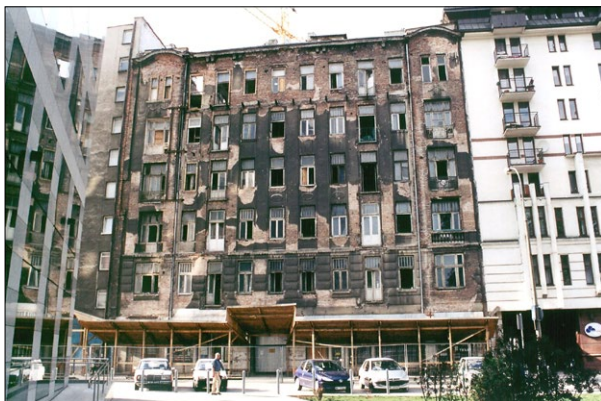
Ryc. 1. Elewacja frontowa budynku; fot. P. Przybysz. Fig. 1. Front elevation; photo by P. Przybysz.
