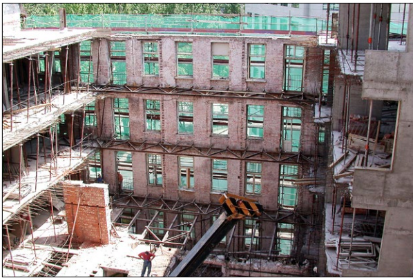
Ryc. 8. Odbudowa budynku (etap III – część środkowa); fot. P. Przybysz.
