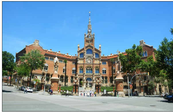
Ryc. 4. Szpital-muzeum Santa Pau w Barcelonie, widok budynku wejściowego do szpitala, 2016.
