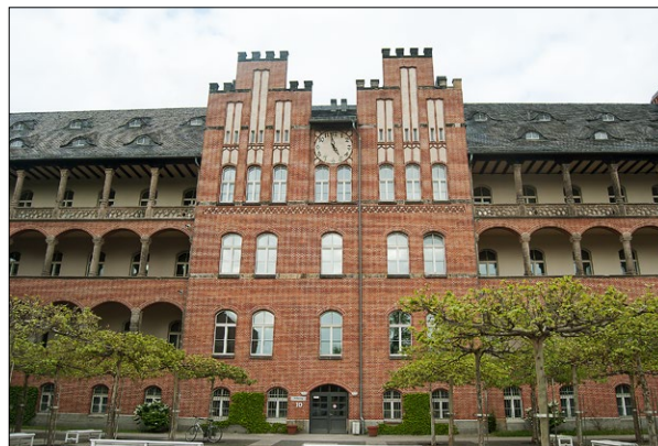
Ryc. 6. Elewacja budynku zespołu klinik Charité w Berlinie przy Virchow Weg 10, 2014.
