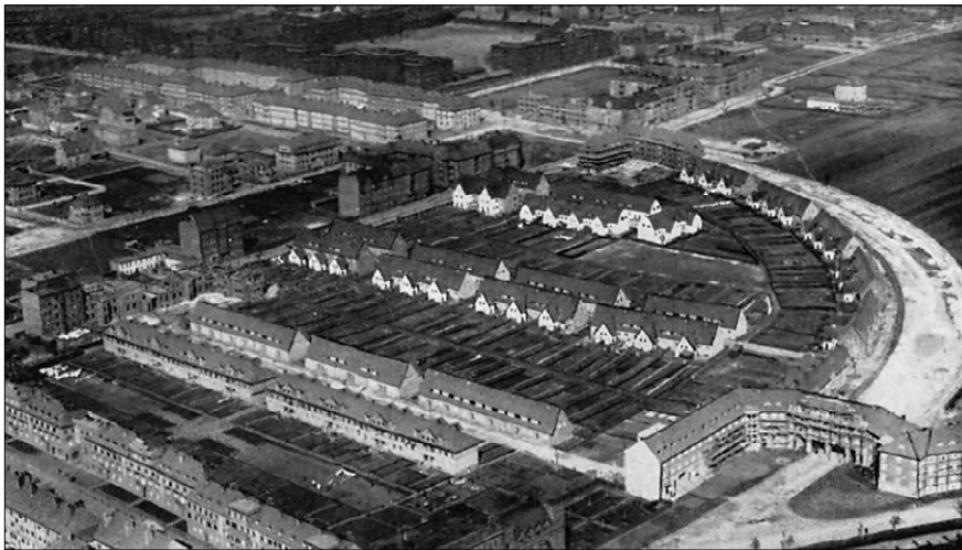
Fig. 3. The Oppeln housing estate, 1920–25; source: K. Maurer, F. Kaminsky, Oppeln, Deutschlands Städtebau , Berlin 1926, p. 69. Ryc. 3. Osiedle Oppeln, 1920–25; źródło: K. Maurer, F. Kaminsky, Oppeln, Deutschlands Städtebau , Berlin 1926, s. 69.
