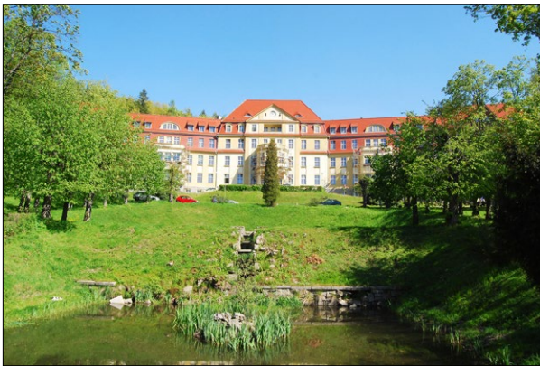
Ryc. 7. Szpital Powiatowe Centrum Zdrowia Bukowiec w Kowarach, widok elewacji południowej, 2013.
