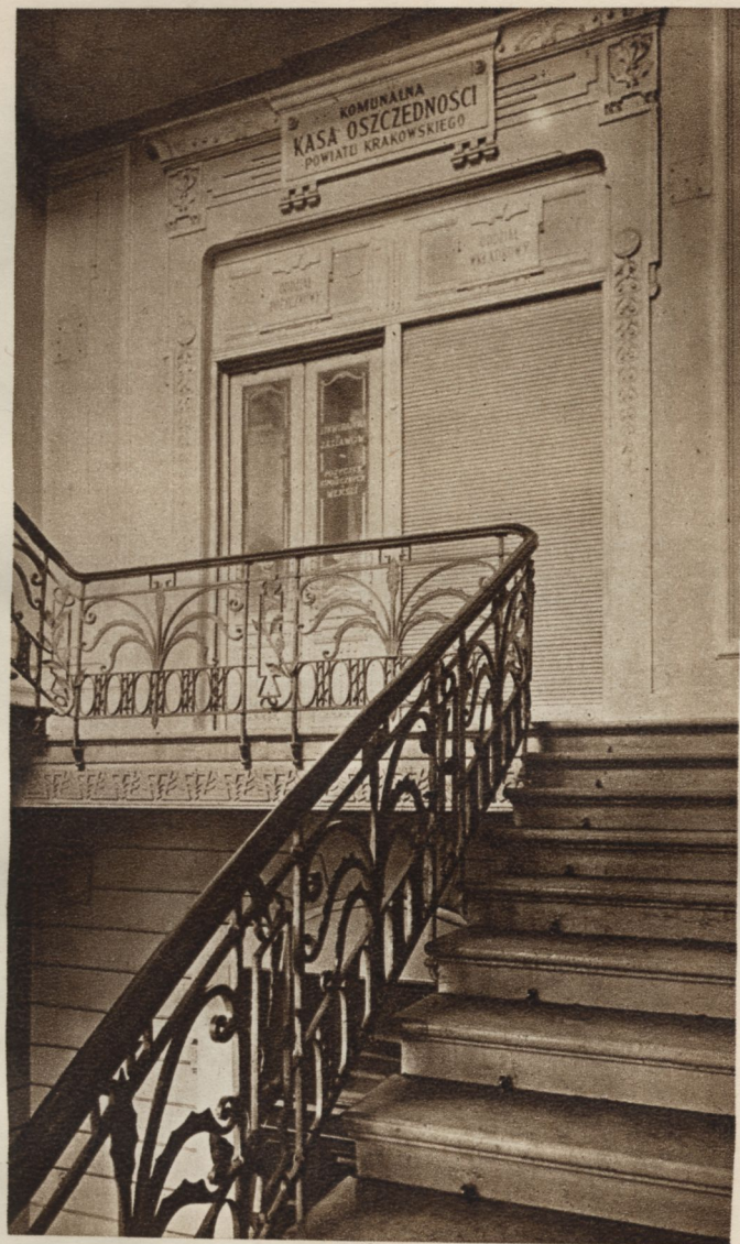
Klatka schodowa i widok na wejście do biur PKKO
