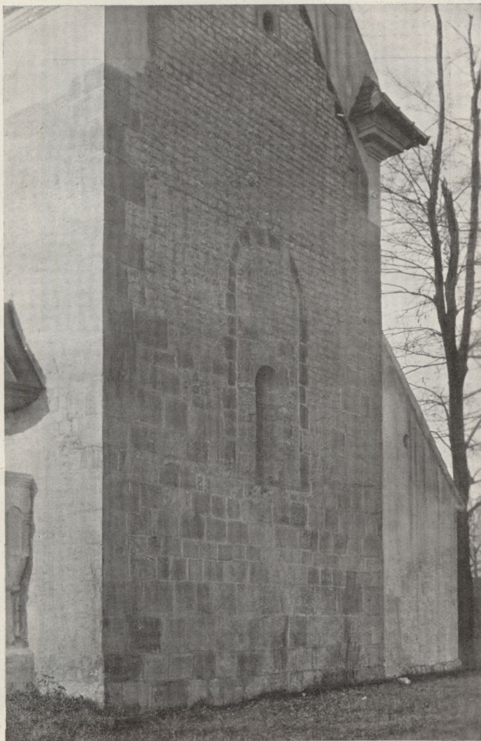
Wątek romańskiego muru (wschodniego) kościola św. Salwatora na Zwierzyńcu.
