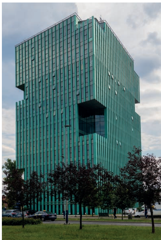
Budynek biurowy Alma Tower (obecnie Pilot Tower) przy ulicy Pilotów w Krakowie. Fot.: Jan Zych
