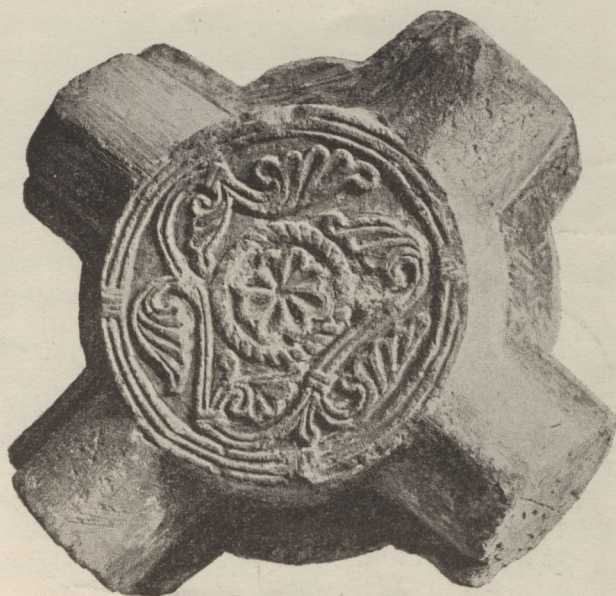
Fig. 5. Jeden ze zworników sklepienia.
