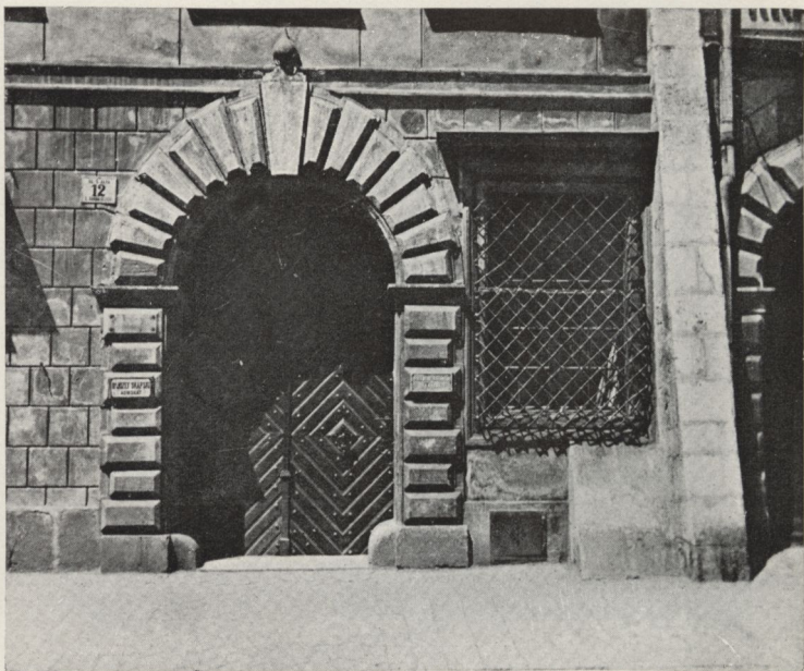
FIG. 2. PORTAL KAMIENICY I FILAR CIOSOWY PRZY KAMIENICY SĄSIEDNIEJ
