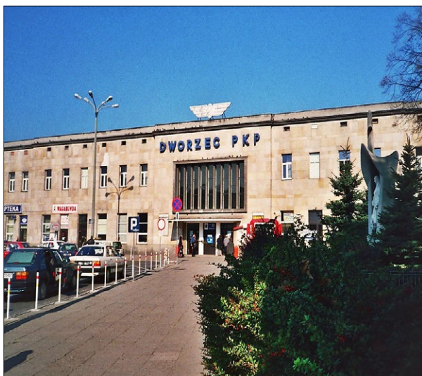
Ryc. 5. Dworzec kolejowy Rzeszów Główny, wrzesień 2001; fot. T. Machowski.
