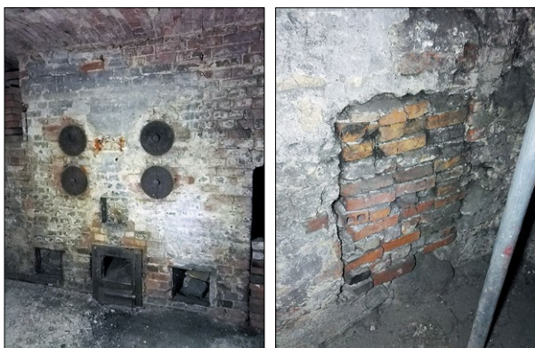
Ryc. 10. Przednia ściana pieca (a); otwór w zachodniej ścianie granicznej zaliczony do V fazy (b).
