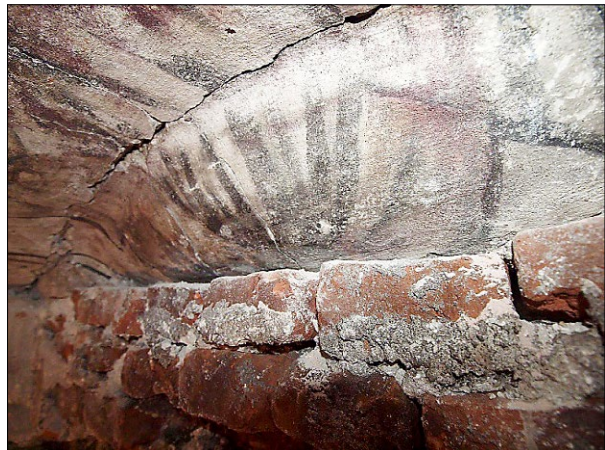
Ryc. 6. Warstwowa budowa ściany zachodniej sali (widok na okno północne) i załamywanie się malowidła na styku warstw, 2019; fot. A. Bojęś-Białasik.
