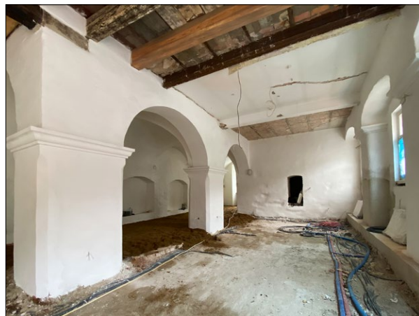
Ryc. 5b. Parter, sień i sala handlu, widok ku wschodowi.
