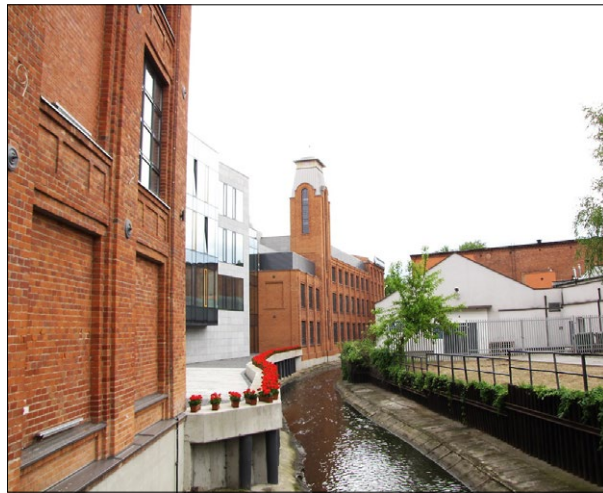
Ryc. 4. Hotel Fabryka Wełny: widok połączenia oryginalnej tkanki z rozbudową, rok. 2019; fot. M. Rudnicka-Bogusz.
