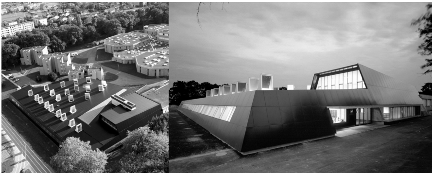
Ilustracja 172: Zadaszenie budynku z widocznym świetlikiem nad holom. Wejście główne.
