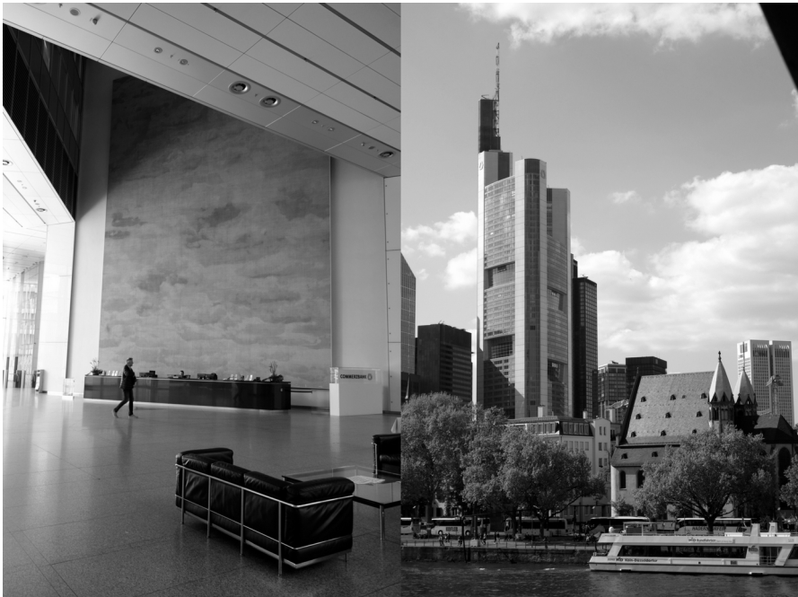
Ilustracja 142: Atrium. Bryła budynku.
