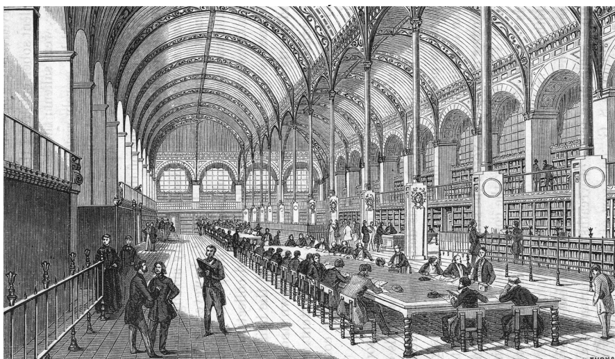
Ilustracja 59: Bibliothèque Sainte-Geneviève, Henri Labrouste, Paryż, 1845 – 1850. Żelazna konstrukcja; uwolniona przestrzeń; dominuje funkcja czytelnia; doświetlona światłem górnym boczным; księgozbiór na dwóch kondygnacjach w sąsiedztwie ścian zewnętrznych.
