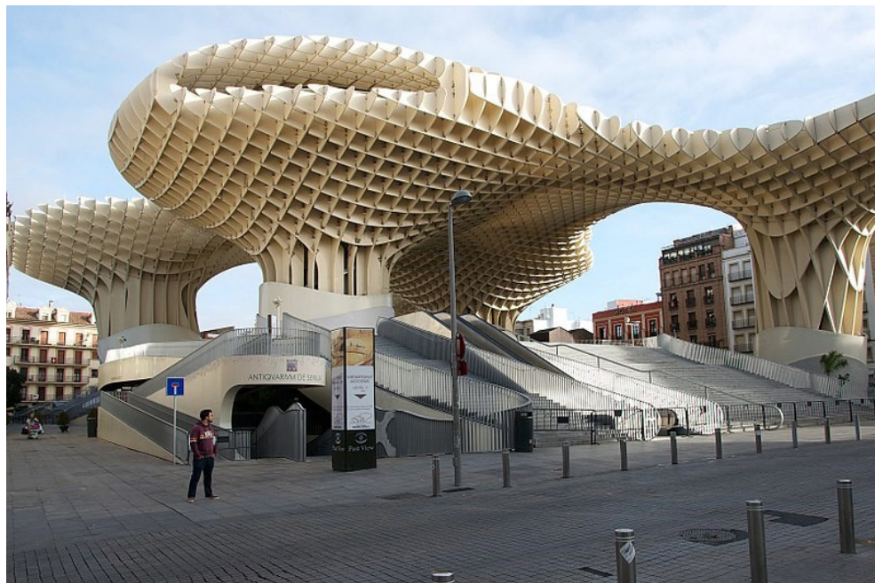
Il. 1. Metropol Parasol w Sewilli jest przykładem budynku inspirującego. Źródło: https://commons.wikimedia.org/wiki/File:Metropol_Parasol_2014_01.jpg (dostęp: 30.11.2022).
