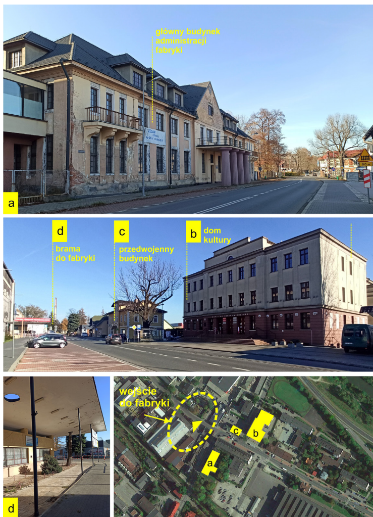
Il. 11. Widok istniejących budynków wokół dawnego wejścia do fabryki: budynek administracji (a), budynek domu kultury i zachowany budynek przyfabryczny z czasów przedwojennych (b), zadaszenie przy wejściu do fabryki (c, d), budowa z czasów powojennych. Fot. i oprac. aut.
