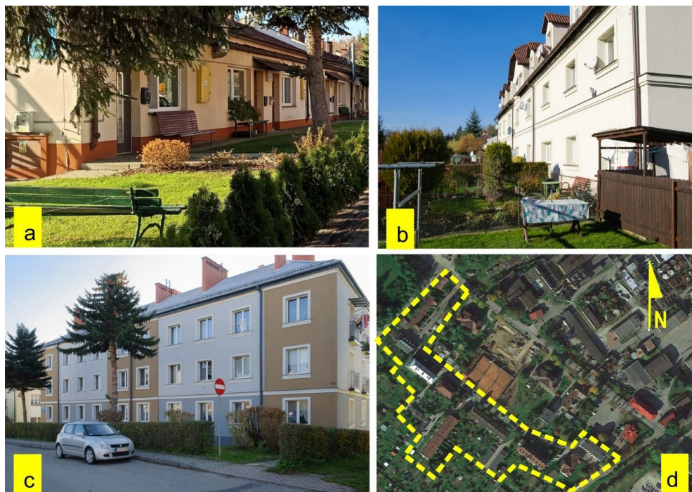
II. 3. Różnorodna typologia zabudowy mieszkalnej dla pracowników fabryki, ul. Ściegiennego. Fot. i oprac. aut. (a, d), J. Matla (b, c)
