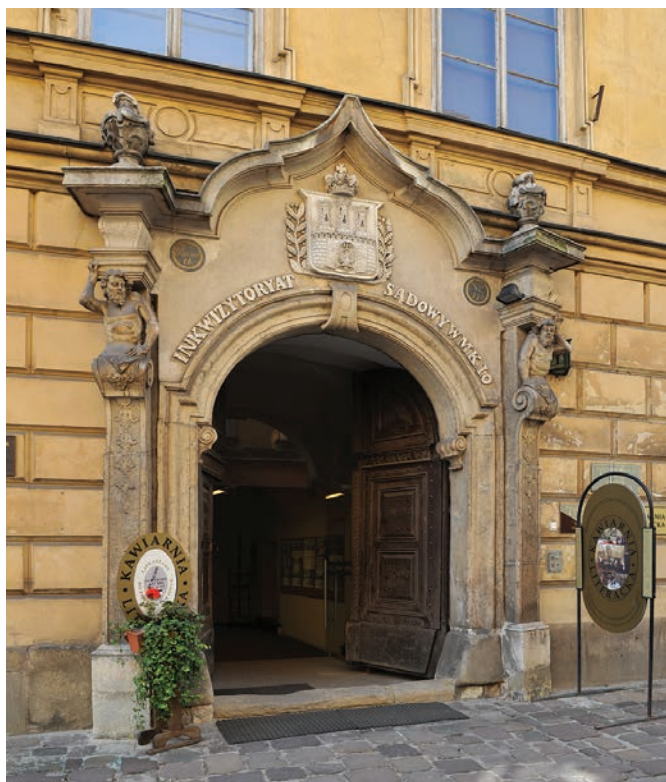
Portal bramy wjazdowej z ulicy Kanoniczej, trzecia ćwierć XVIII wieku
