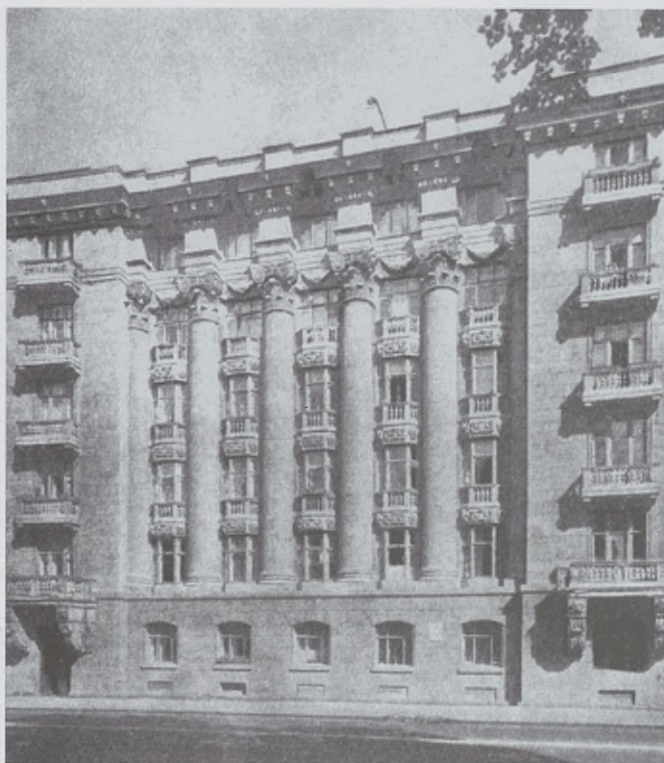
Il. 403. Kamienica czynszowa. Petersburg. W. A. Szczuko, 1909–1911
