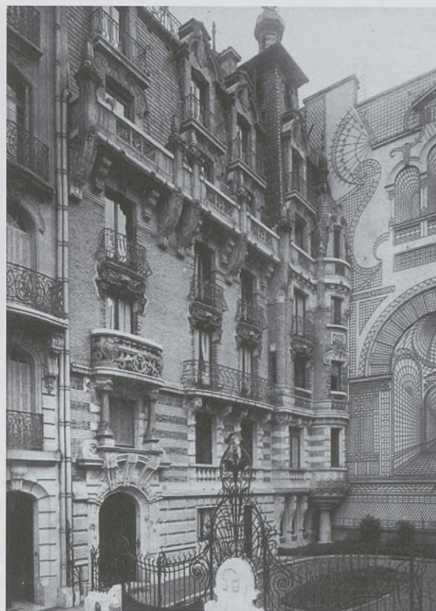
Il. 279. Kamienica czynszowa. Place Rap, Paryż. J. A. Lavirotte, 1899
