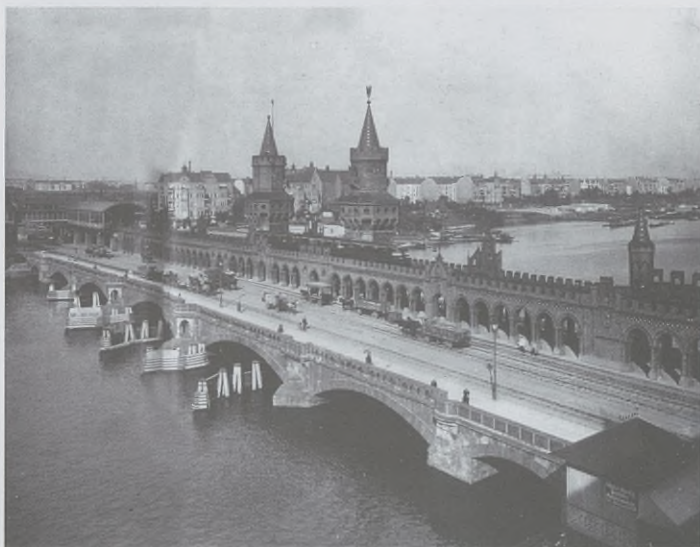
Il. 324. Most i wiadukt Oberbaum. Berlin. 1905
