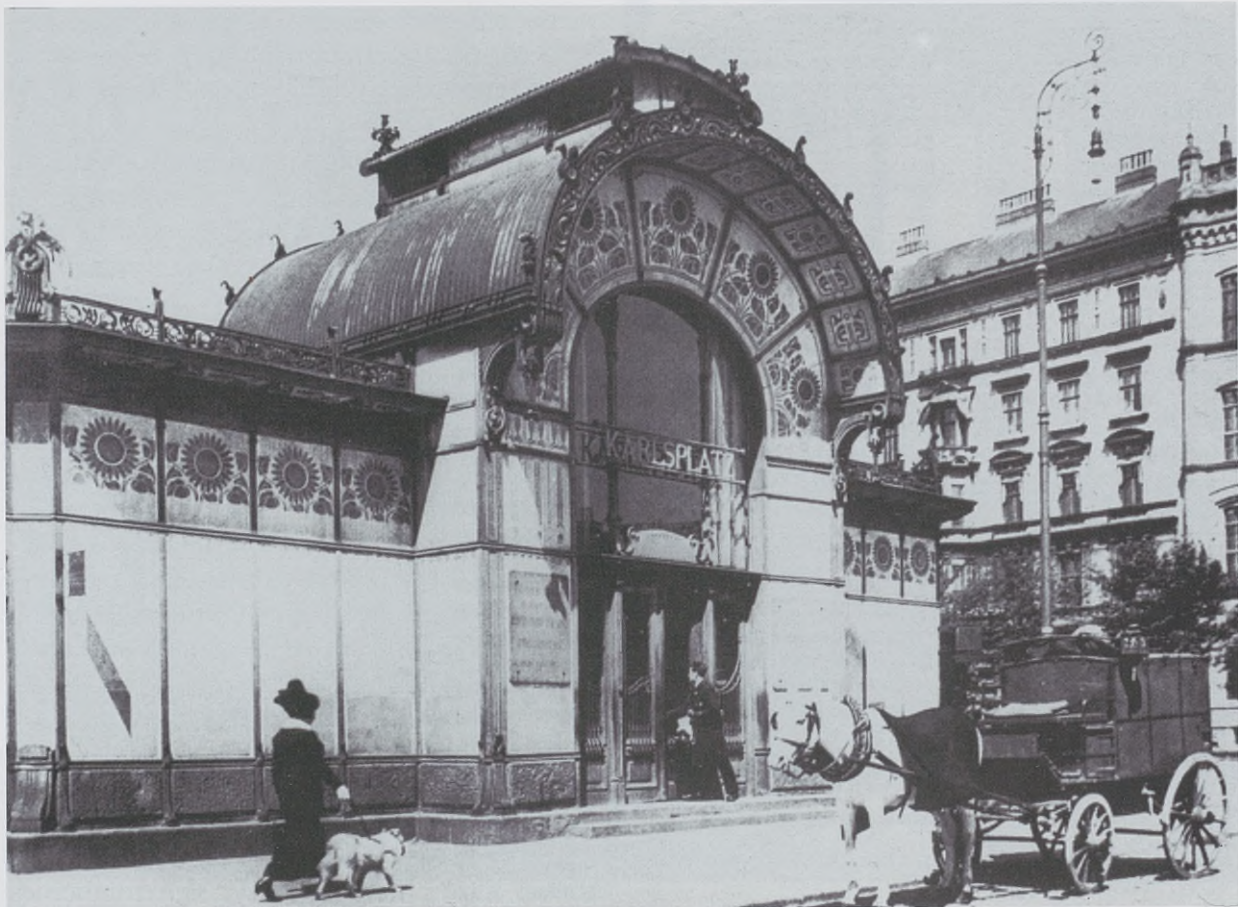
Il. 249. Stacja Karlsplatz. Wiedeń. O. Wagner, 1899–1900
