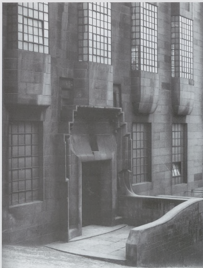
Il. 255. Biblioteka Szkoły Artystycznej, fragment fasady zachodniej. Glasgow. Ch. R. Mackintosh, 1907–1909
