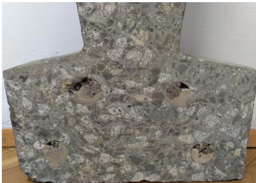
Fot. 44. Widok przekroju badanego elementu – niepełna iniekcja kanałów kablowych.
