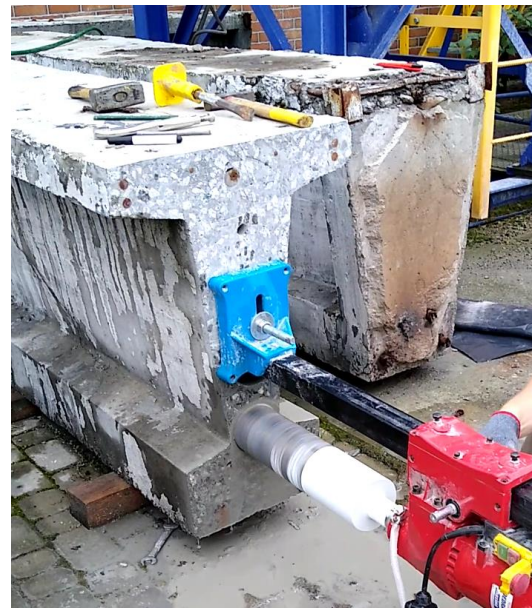
Fot. 57. Pobieranie betonowych odwiertów rdzeniowych.
