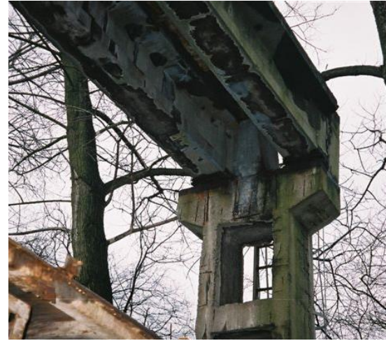
Fot. 2. Zewnętrzna estakada podsuwnicowa z belek kablobetonowych.
