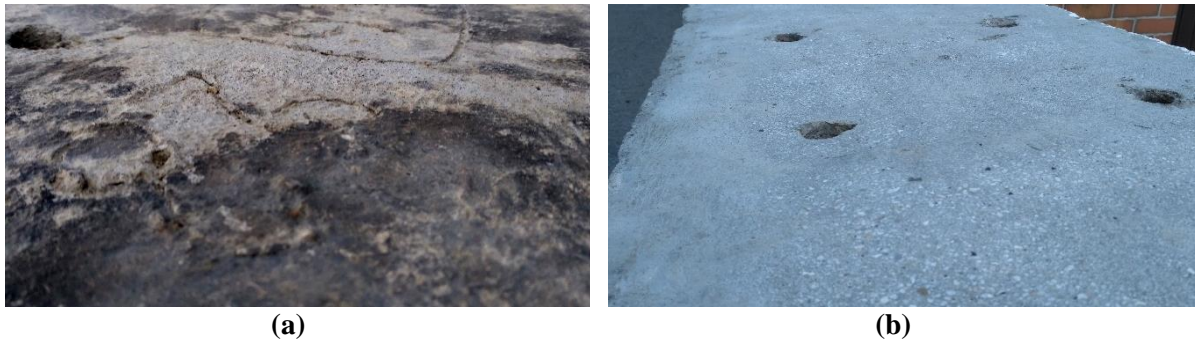
Fot. 39. Powierzchnia górna belki a) przed szlifowaniem i b) po szlifowaniu.
