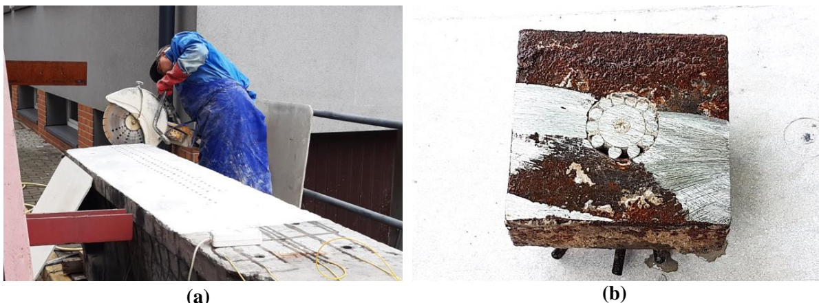
Fot. 41. a) Odcinanie zakotwienia przy użyciu piły tarczowej; b) widok odciętego zakotwienia kabla.
