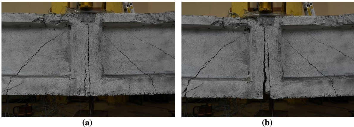
Fot. 13. Widok elementu B 3-0 a) bezpośrednio przed zniszczeniem; b) zniszczenie w strefie styku.
