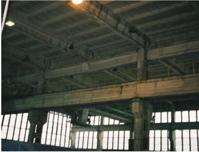
Fot. 1. Kablobetonowe belki podsuwnicowe wewnątrz hali przemysłowej.
