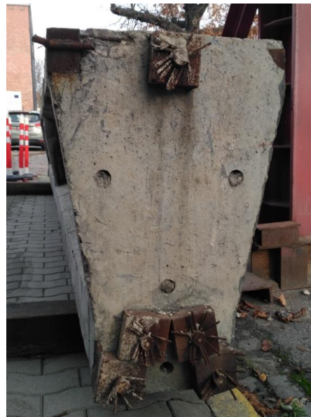
Rys. 36. Analizowany dźwigar kablobetonowy a) układ zakotwień (A-A, rys. 35); b) widok.
