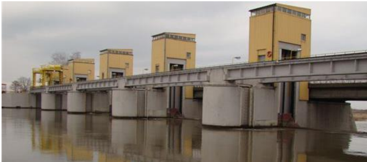
Fot. 3. Zewnętrzna estakada podsuwnicowa nad stopniem wodnym.
