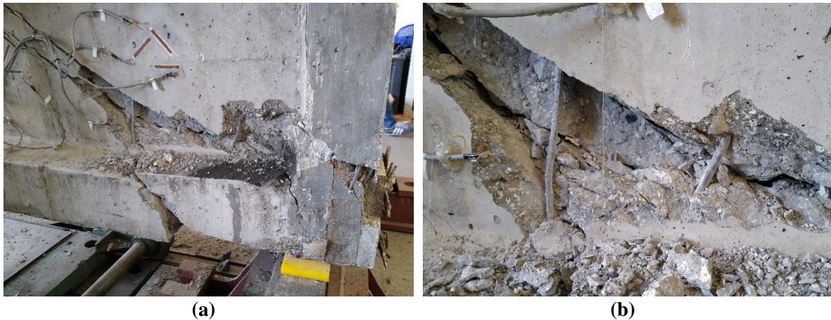
Fot. 26. a) Deplanacja czoła belki i przemieszczenie względem rysy ukośnej, b) strzemiona w rejonie zmiażdżonego krzyżulca – badanie B 1-1a.
