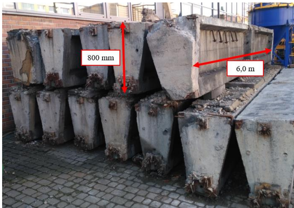
Fot. 7. Prefabrykowane belki kablobetonowe przeznaczone do badań.
