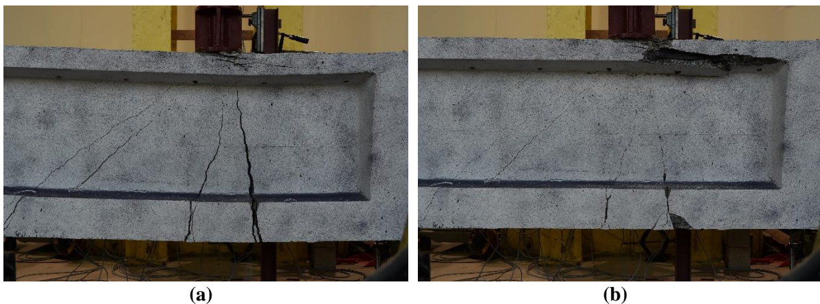
Fot. 16. Widok elementu B 2-0 a) przed zniszczeniem, b) po odciążeniu – zmiężdżenie betonu w strefie ściskanej oraz zwrot sprężysty i zaciśnięcie zarysowań.
