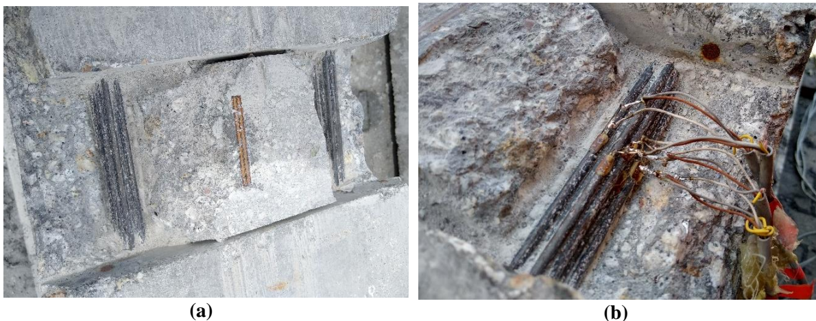
Fot. 49. a) Przygotowanie kabla sprężającego; b) tensometry na powierzchni drutów dla badania S-1b.
