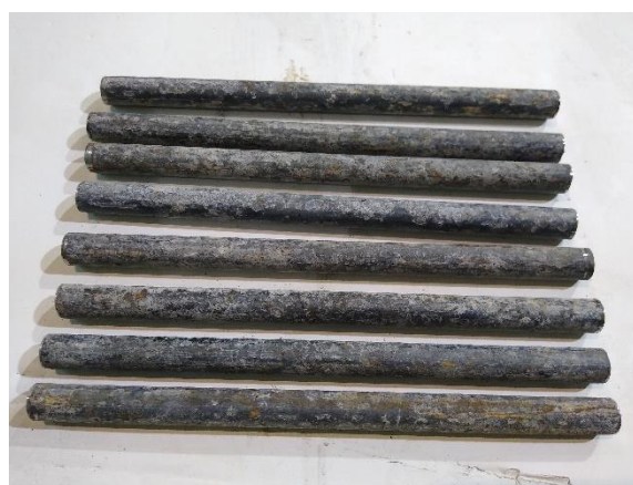
Fot. 54. Widok próbek gładkich prętów zbrojeniowych \varnothing 16 .
