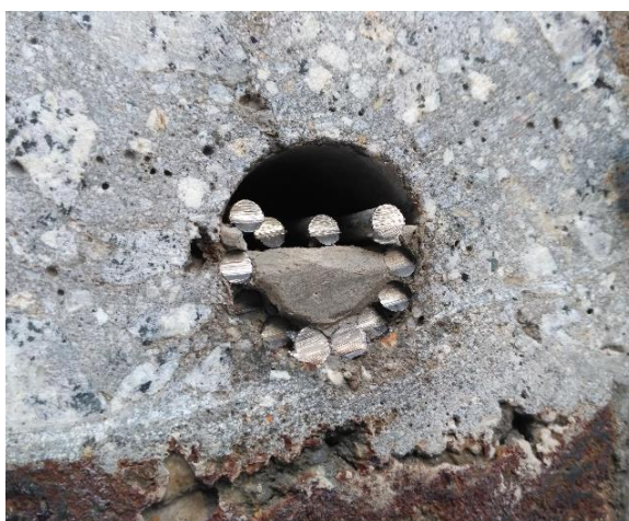
Fot. 42. Widok czola kabla sprężającego.
