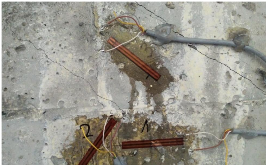
Fot. 20. Tensometr rejestrujący odkształcenia w wydzielonym ściskanym krzyżulcu betonowym
