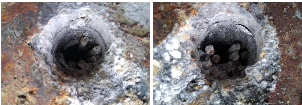
Fot. 51. Widok iniekcji kanałów kablowych w elemencie B 3-2, a) kanał nr 1; b) kanał nr 2.
