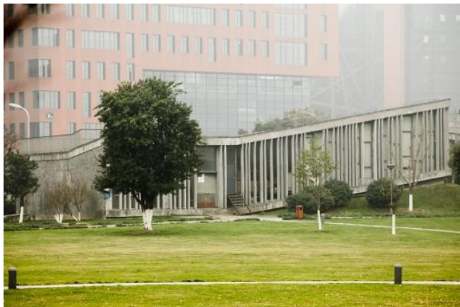
Fot. 31. Budynek biurowy Twisting and Undulating
