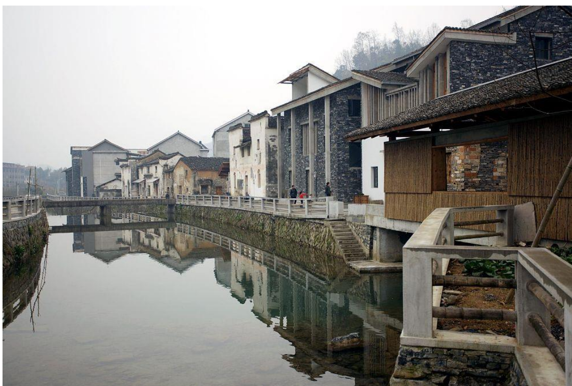
Fot. 45. Widok na zabudowę od strony rzeki. Elementy poddane modernizacji mieszają się organicznie z istniejącą zabudową
