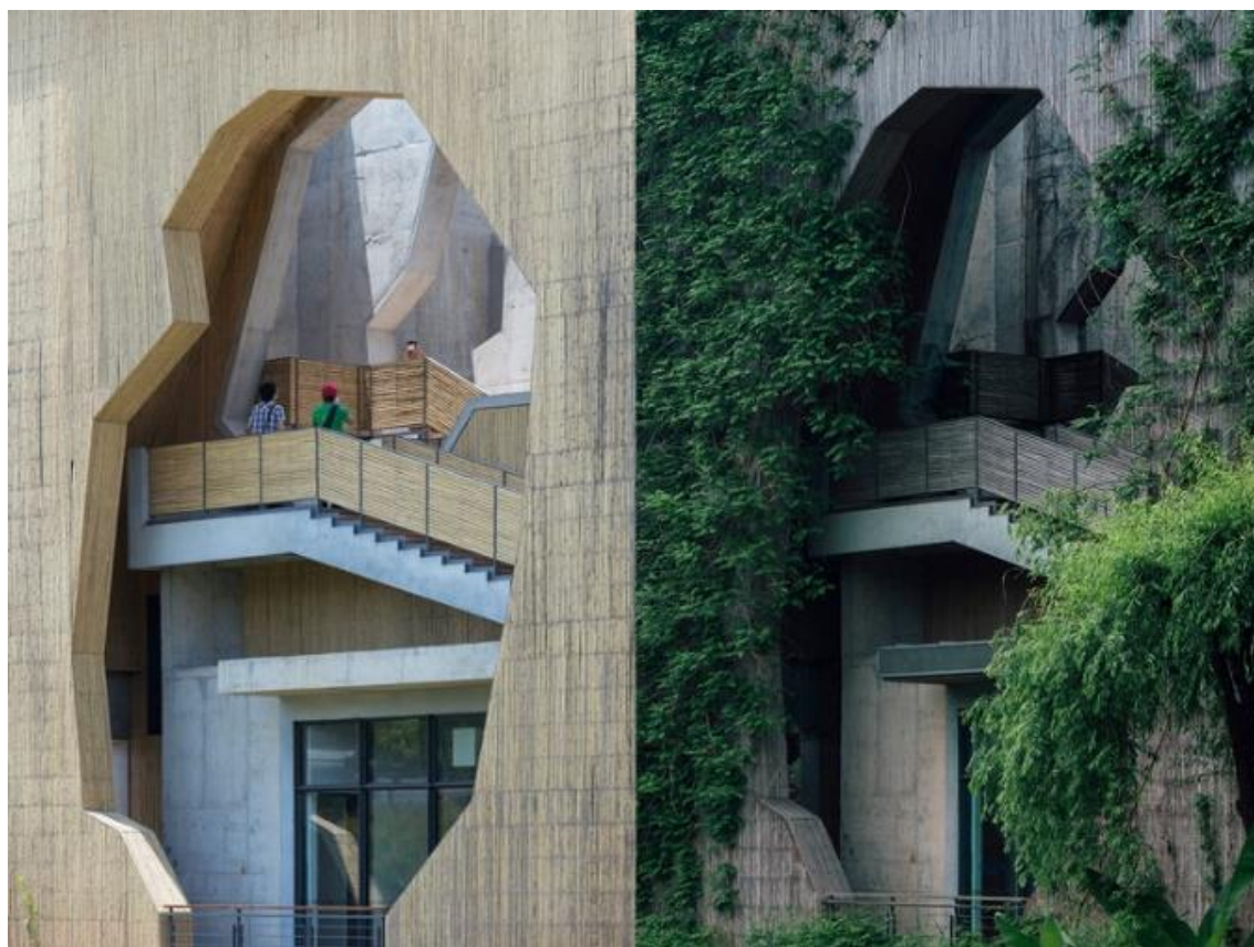
Fot. 59. Kampus Xiangshan w 2007 r. (po lewej, fot. Iwan Baan) i w 2021 r. (po prawej, fot. YanGu Studio)
