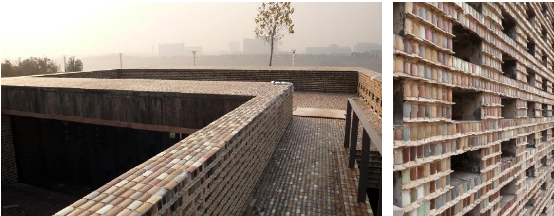
Fot. 16. Taras oraz detal wykończenia ściany (fot. Lu Hengzhong)
