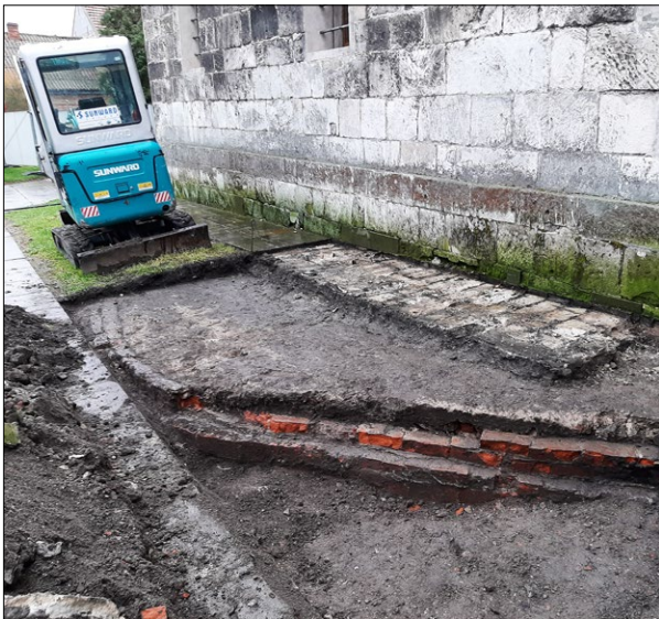
Ryc. 1. Wykop archeologiczny przy północnej elewacji kolegiaty w Wiślicy, 2020; fot autorzy
