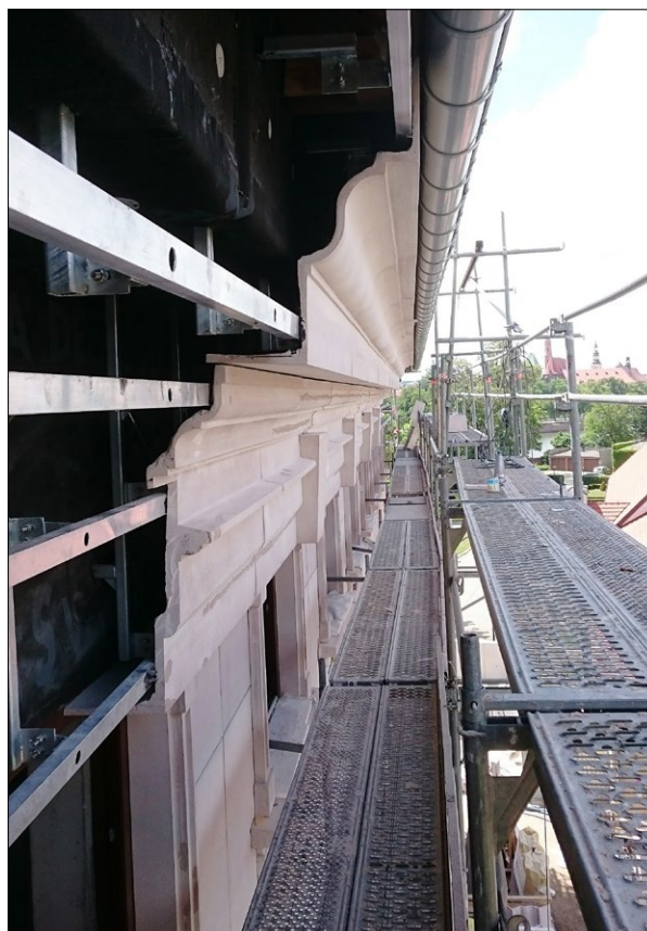
Ryc. 8. Technologia wykonania elewacji z betonowych płyt GRC na podkonstrukcji aluminiowej, 2016; fot. J. Gomółka
