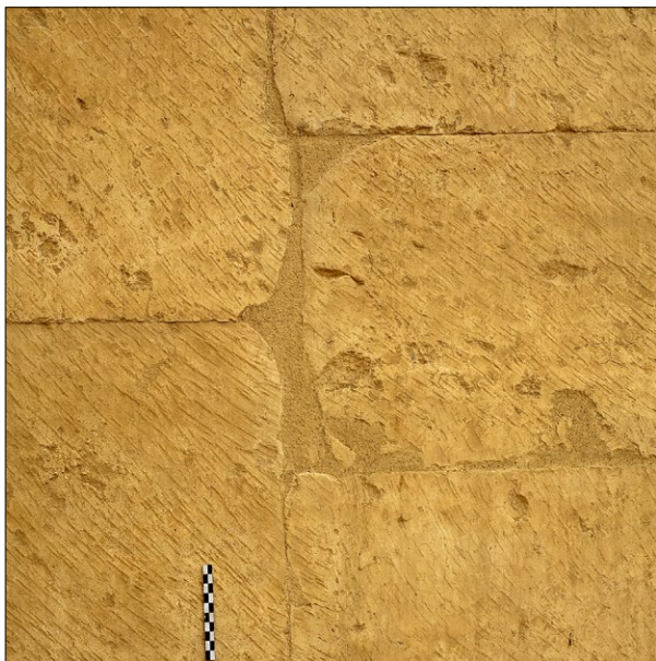
Ryc. 4. Obrobione lico ściany – widoczne ślady po młotku kamieniarskim, Zespół Kultu Słońca; fot. T. Dziedzic
