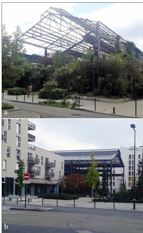
Ryc. 9. Jardin des Fonderies; a) hala dawnej odlewni adaptowana na zadaszony ogród miejski, b) jej nowy kontekst urbanistyczny; fot. B.M. Walczak
