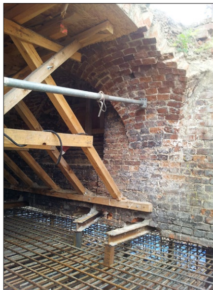
Ryc. 6. Zachowane fragmenty oryginalnych pozostałości historycznego budynku. Roboty żelbetowe – zbrojenie płyty fundamentowej; fot. J. Gomółka
