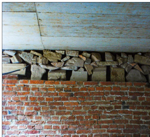
Ryc. 10. Zachowane barokowe mury w kondygnacji podziemnej skrzydła zachodniego, 2016; fot. J. Gomółka
