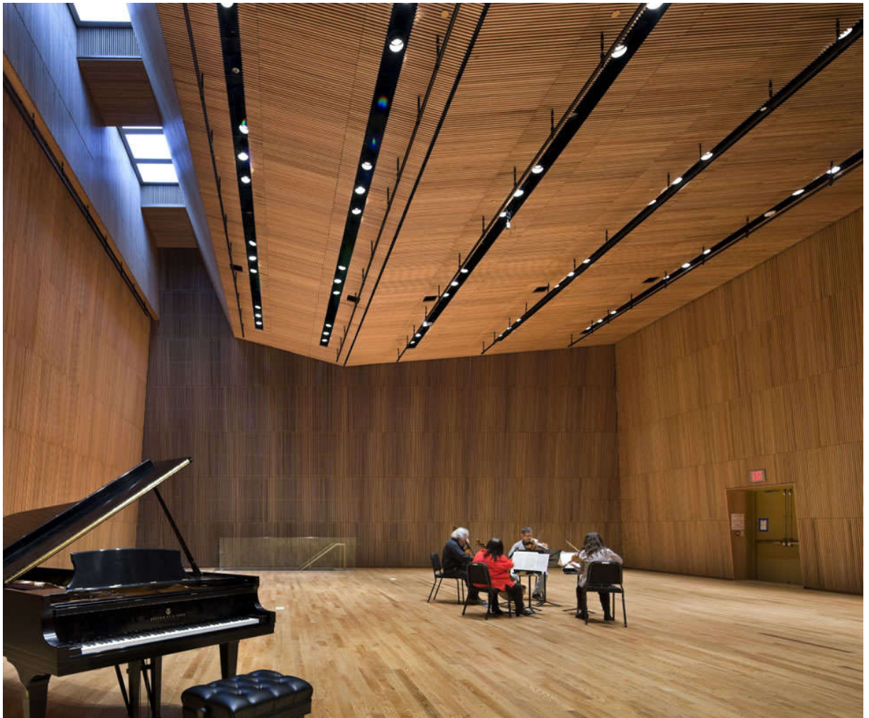
Ilustracja 27. The DiMenna Center for Classical Music, New York, USA. Architektura: H3. Przykład zastosowania odchylenia od pionu przeciwległych ścian sali prób oraz zastosowania sufitu podwieszanego o różnych kątach nachylenia w celu uniknięcia niepożądanego efektu echa trzepoczącego.
