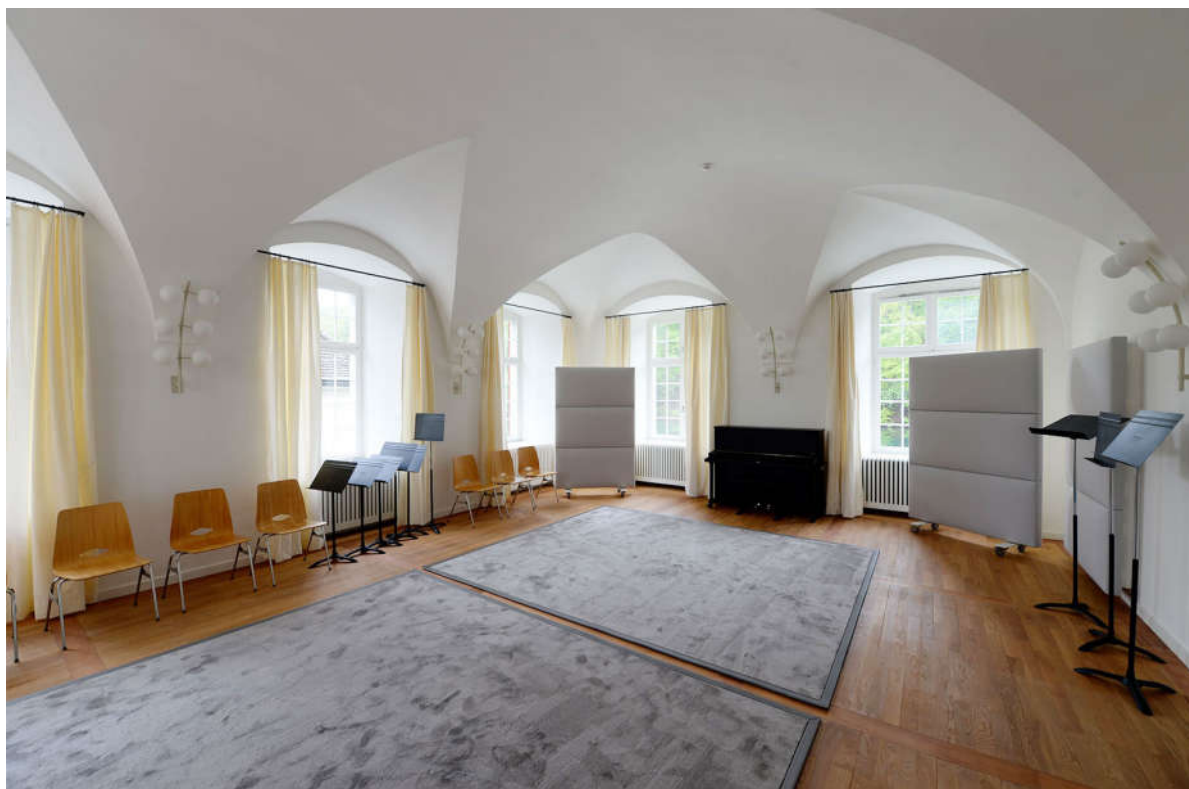
Ilustracja 21. Sala prób z ruchomymi absorberami, zapewniającymi szybką i łatwą zmianę czasu pogłosu w pomieszczeniu. Musik Insel, Rheinau, Szwajcaria. Adaptacja akustyczna wg projektu Kahle Acoustics. [https://www.musikinsel.ch/de; dostęp: marzec 2021]
