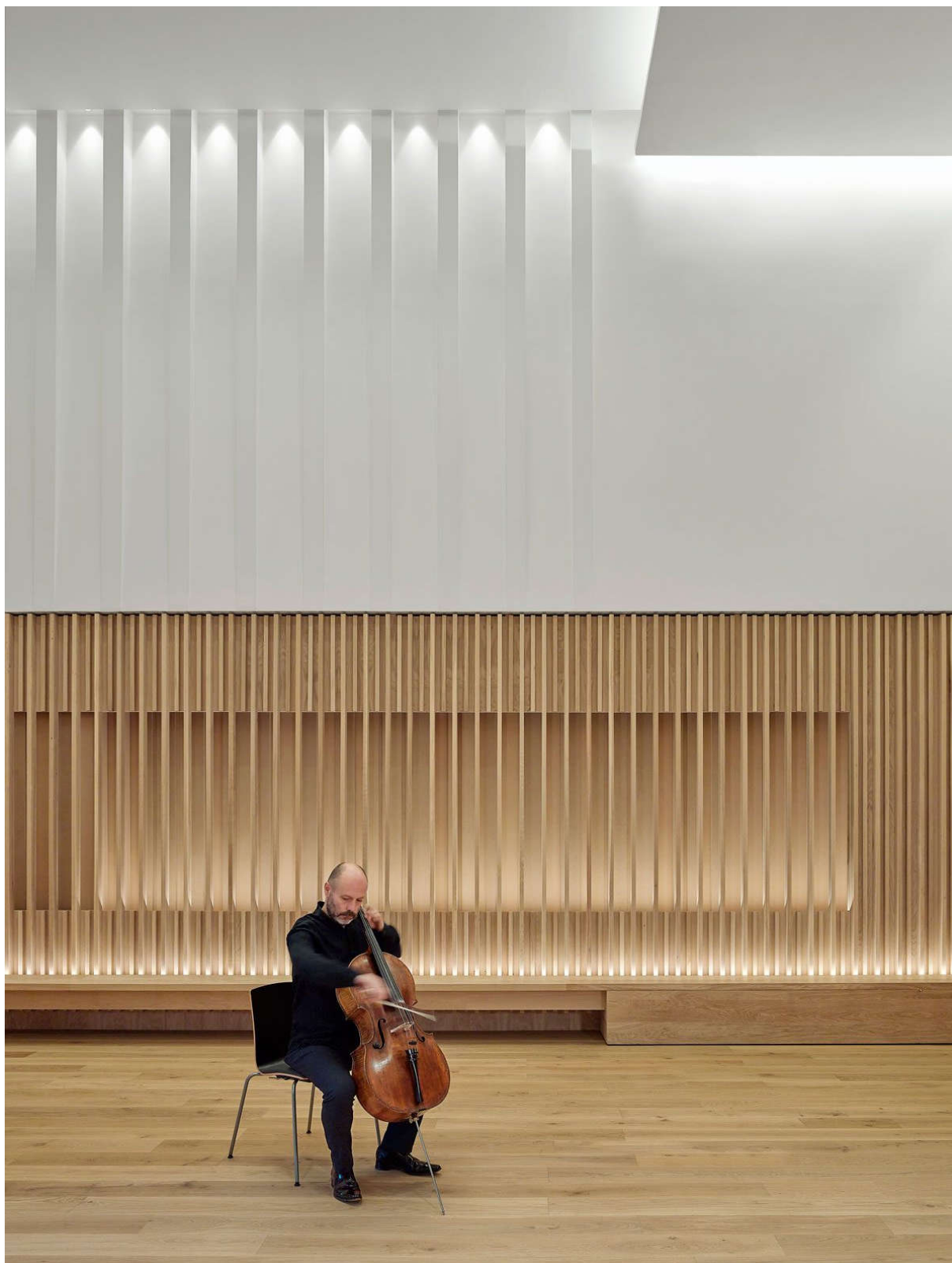
Ilustracja 18. The Oglesby Centre at Halle St Peter's, Manchester, Wielka Brytania – sala prób dużych zespołów muzycznych. Architektura: Stephenson STUDIO. Przykład zastosowania paneli pochłaniających dźwięk na wysokości użytkowników sali prób. [www.ribaj.com, dostęp: styczeń 2021]
