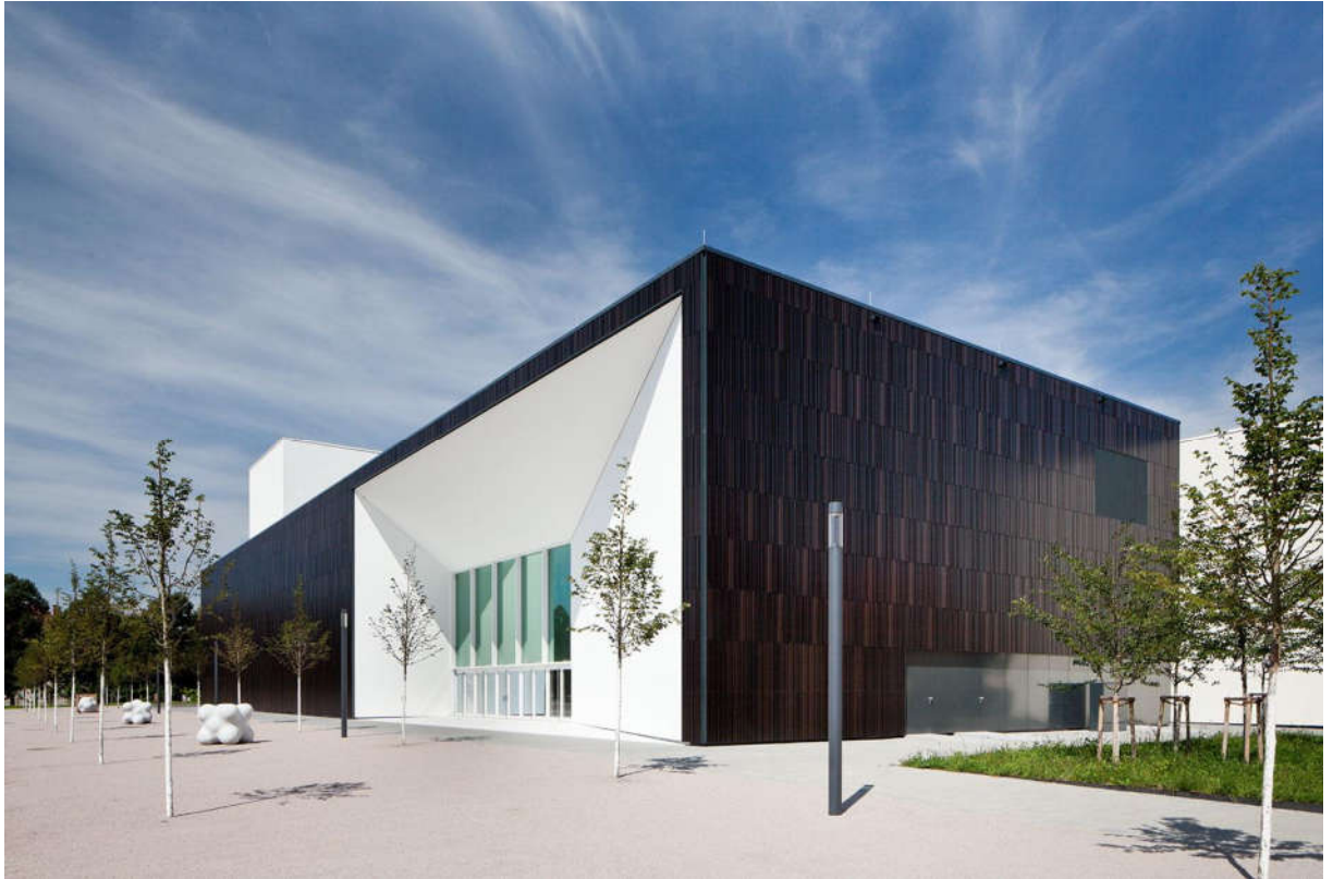
Ilustracja 75. Campus One, Karlsruhe - bryła budynku Multimedia Complex. [www.jung.de, dostęp: maj 2018]
