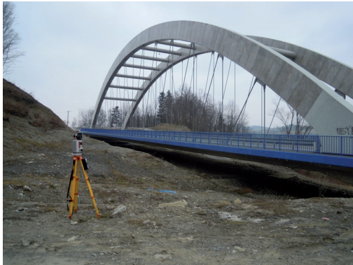
Il. 9. Przykładowe stanowisko pomiarowe (marzec 2019). Fot. K. Tomaszewicz
