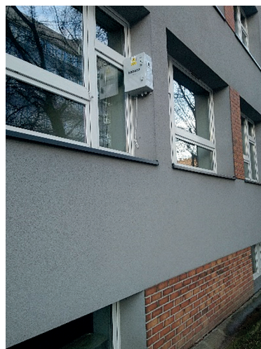
Il. 5. Miernik Looko2 na ścianie zewnętrznej budynku L-1. Fot. aut.
