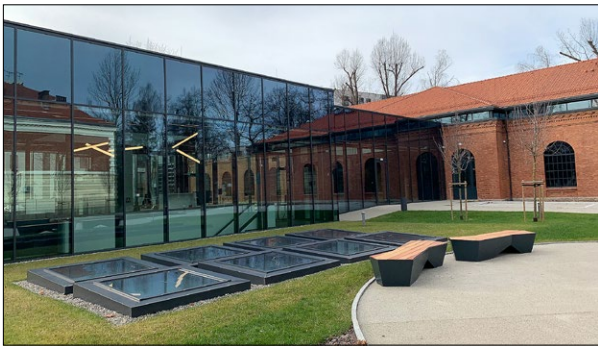
Ryc. 6. MuFo, widok z zewnątrz po przebudowie; fot. Marek Pabich Fig. 6. MuFo, exterior view after remodeling; photo by Marek Pabich
