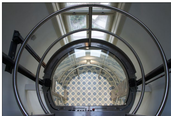
Ryc. 10. Widok na kabinę dźwigu z góry, przez szklany sufit widoczne jej wnętrze, 2020; fot. R. Jeżowski
