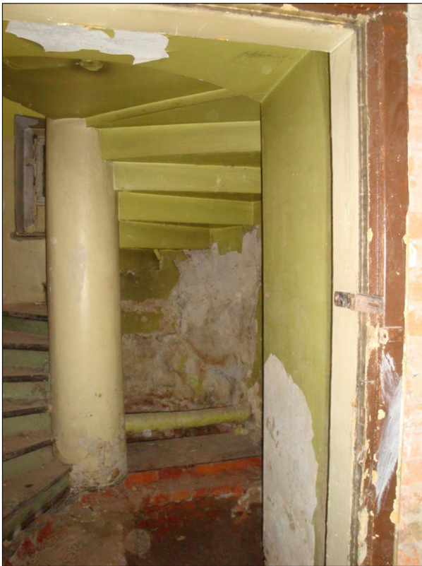
Ryc. 2. Wejście z piwnicy do klatki schodowej w baszcie przed rozbiórką, 2018; fot. R. Jeżowski
