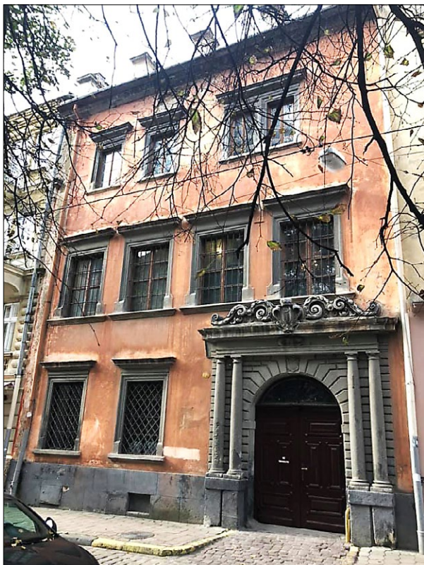
Ryc. 1. Kamienica Królewska, widok od ul. Fedorowa, widoczne cztery okna Sali Reprezentacyjnej na pierwszym piętrze, 2021; fot. L. Hanuliak
