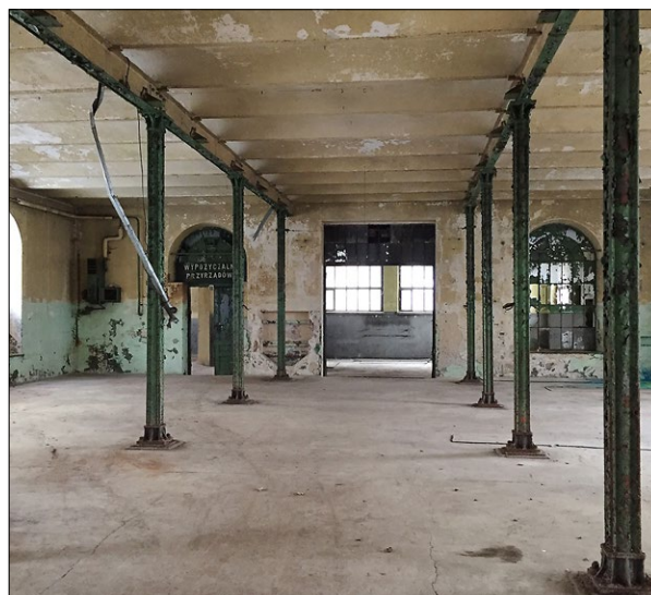
Ryc. 2. Zbrojownia, wnętrze parteru, 2016; fot. Marek Pabich Fig. 2. Armory, first floor interior, 2016; photo by Marek Pabich
