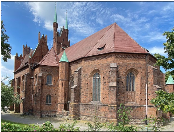
Ryc. 2. Kościół parafialny pw. św. Michała Archanioła, widok od wschodu; fot. autor
