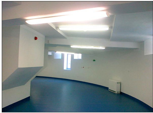
Fig. 8. Part of the ground floor after thermal retrofitting and interior finishing, 2013; photo by P. Opalka Ryc. 8. Część parteru po termomodernizacji i wykończeniu wewnątrz, 2013; fot. P. Opalka
