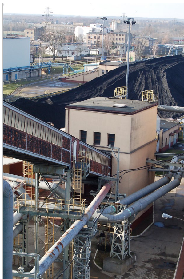
Ryc. 5. Zespół EC-2 przed pracami demontażowymi; fot. B.M. Walczak
