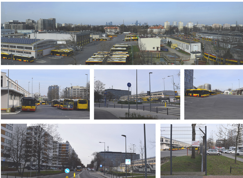
Il. 6. Zajezdnia autobusowa widziana od strony ul. Konstruktorskiej, 2023. Fot. M. Duda
