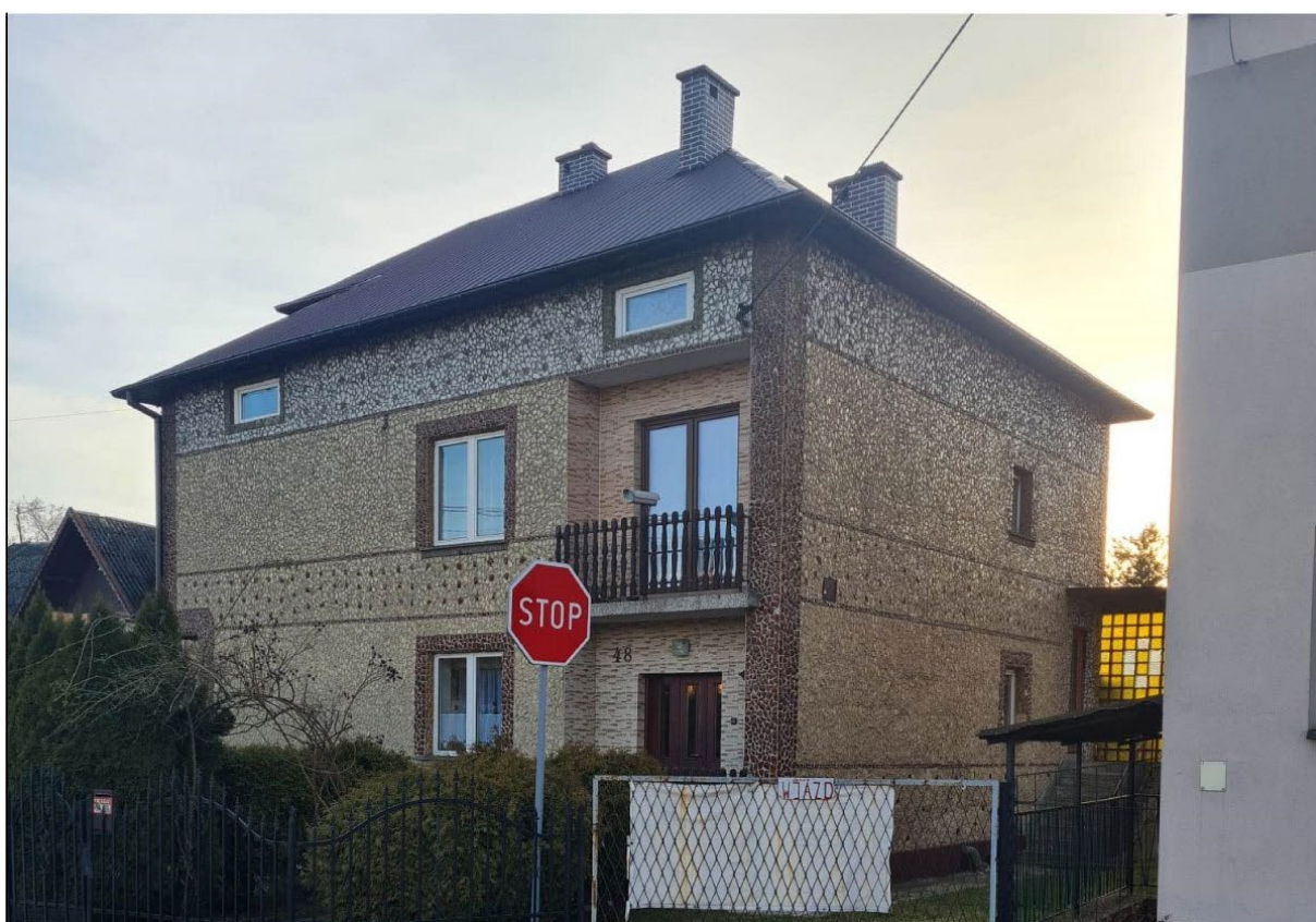
Zd. 7. Dekoracja domu wykonana w tynku
