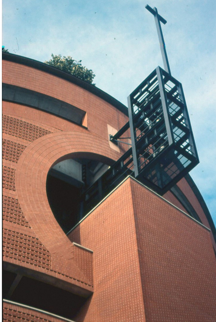
Il. 7. Katedra w Évry – fragment elewacji zewnętrznej, fot. J. Gyurkovich
