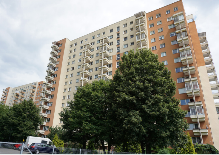
II. 2. Budynki w technologii ramy H przy ul. Skalskiego. Autor zdjęcia Anita Orchowska
