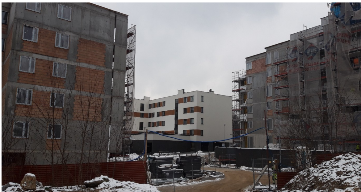
Fot. 6. Widok omawianego przedsięwzięcia w fazie realizacji od strony wschodniej. Stan w rozpatrywanym okresie – drugi miesiąc po reorganizacji (źródło: fot. autorki)
