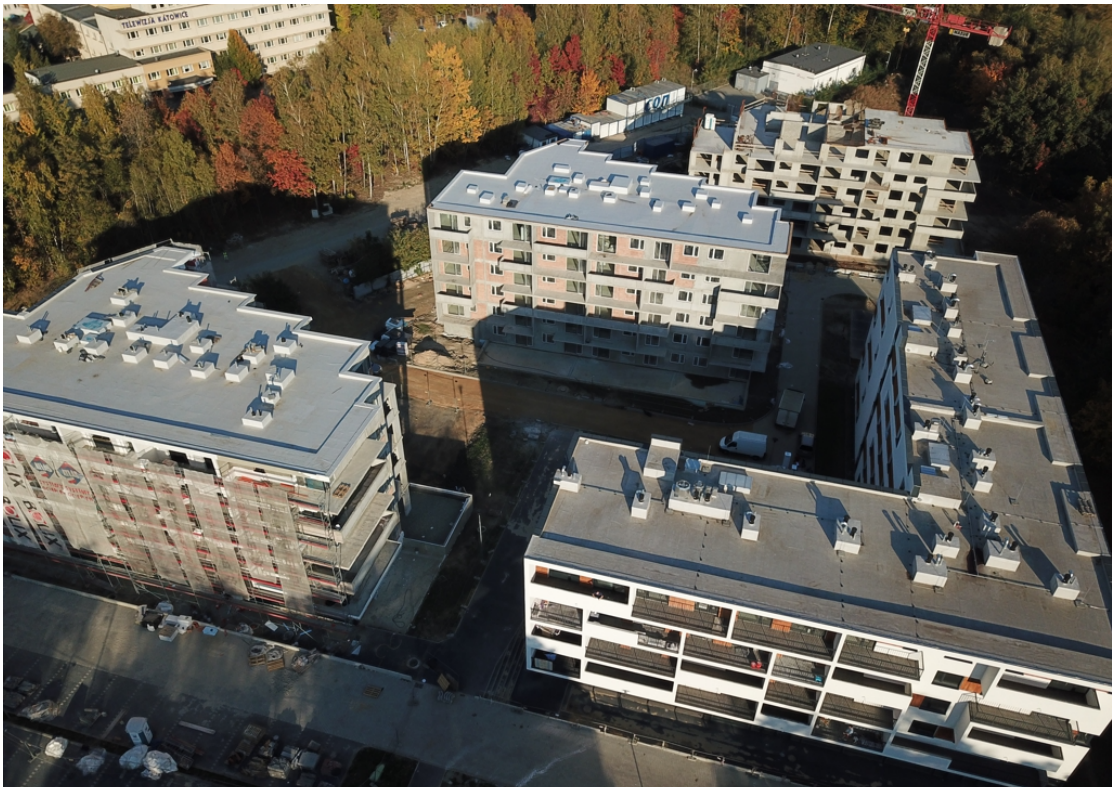
Fot. 2. Widok z drona przedsięwzięcia w fazie realizacji od strony północnej (źródło: miasto.pro)
